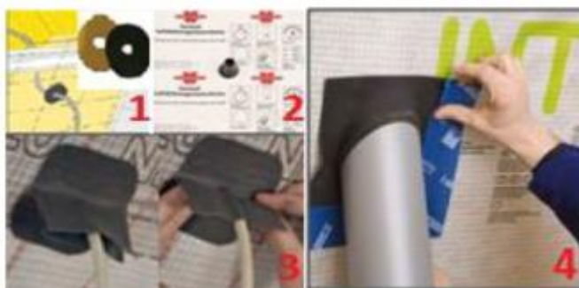
Passages de réseaux traités de manière étanche entre un local du volume chauffé donnant sur un local technique
