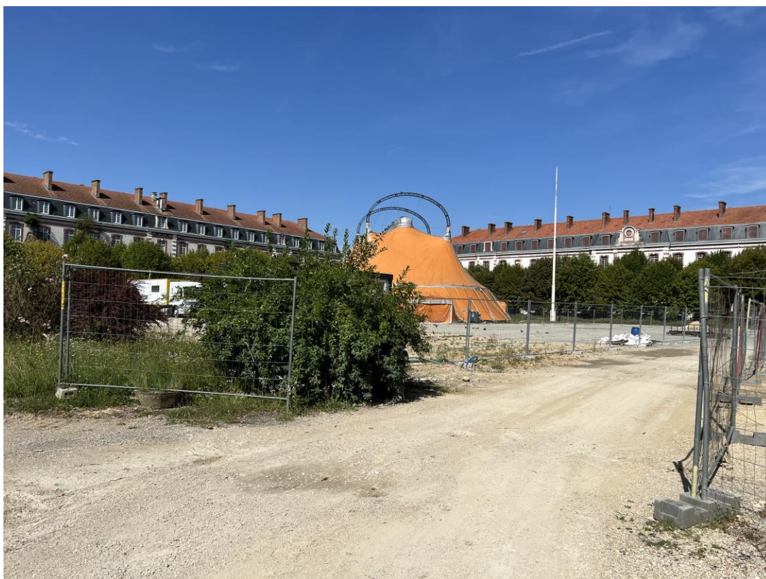
Vue de la partie Sud du site (Orientée Nord)
