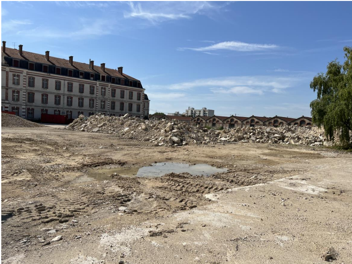
Vue de l'implantation du futur parking silo (vue orientée Sud)
