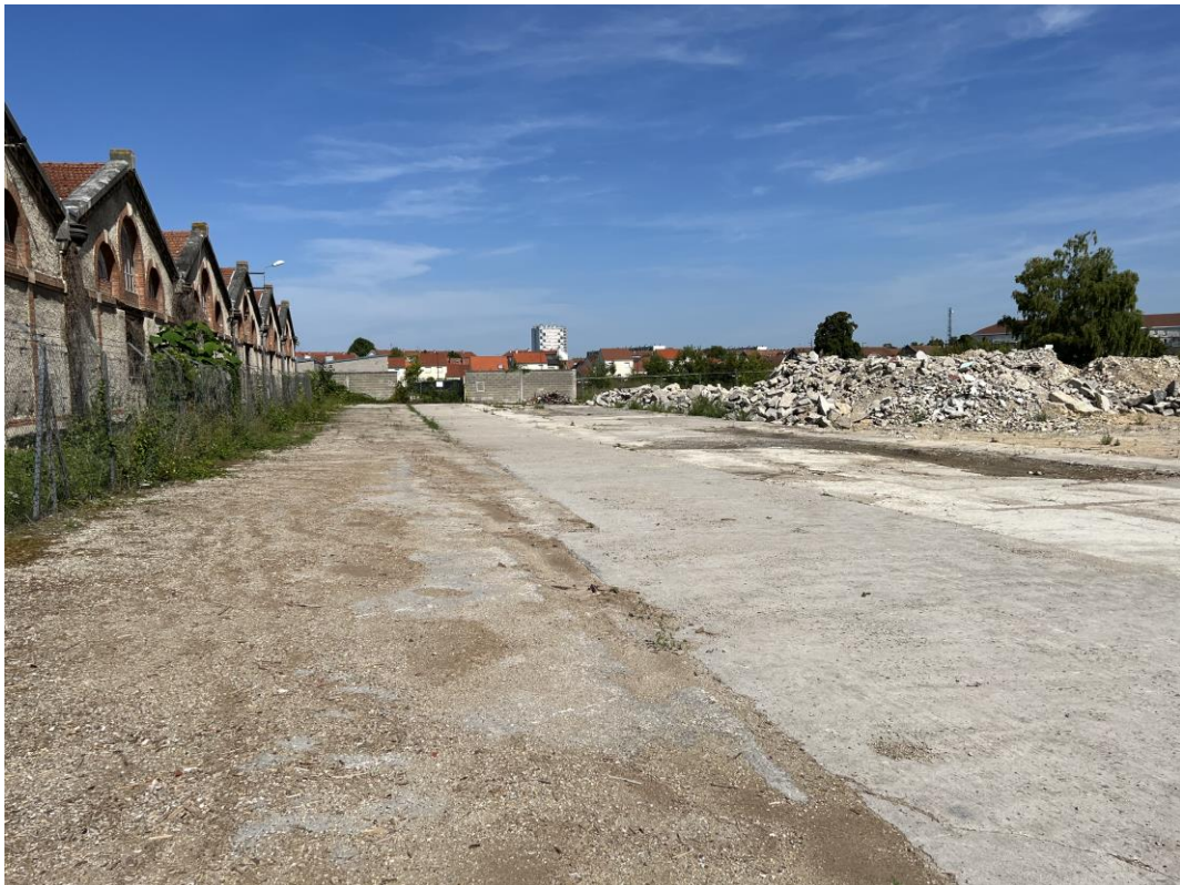
Vue de l'Est du site (orientée Nord)
