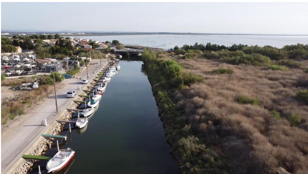
Photo 3 : Vue rapprochée sur le quai actuel et le parc à bateau
