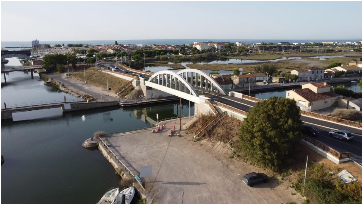
Photo 5 – Vue éloignée sur la zone sud du projet avec le canal du Rhône à Sète
