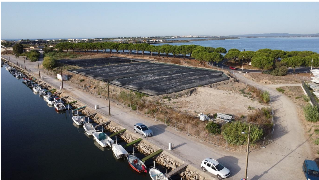
Photo 1 : Vue drone éloignée sur la zone de stockage de sédiments en 2023
