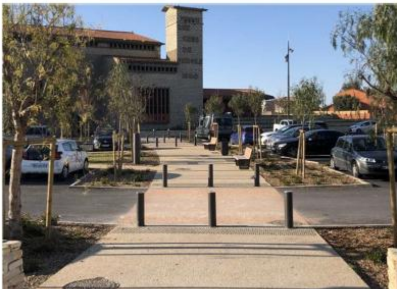
Figure 11 : Exemple de cheminement en béton désactivé – Place du Général de Gaulle à Pérols (34)
