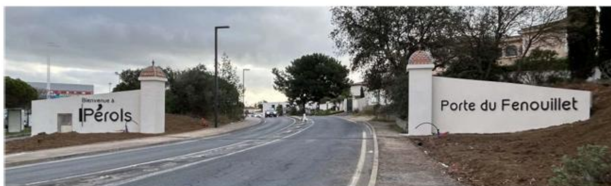
Figure 15 : Exemple de la porte du Fenouillet en cours de travaux – Pérols (34)
