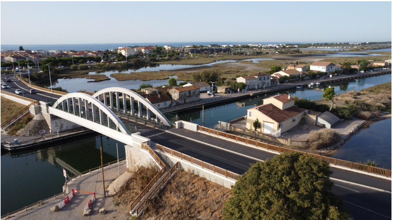
Figure 8 : Cheminement d'accès à une habitation privée (Cisma Environnement, 2024)
