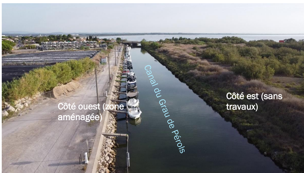
Figure 24 : Photographie du canal du Grau de Pérols
