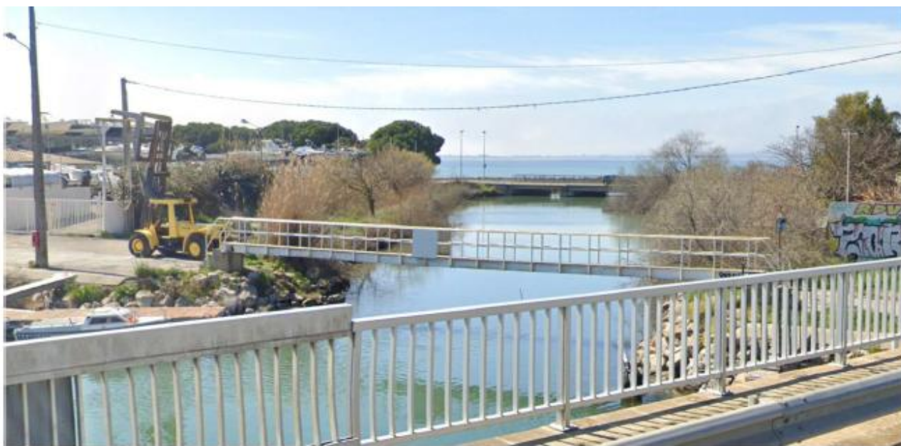
Figure 14 : Vue de la passerelle piétonne à renouveler
