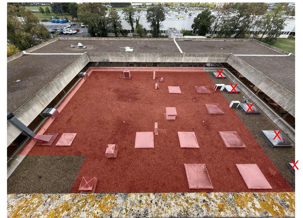
Vue 03 - partie du niveau 0 à démolir
