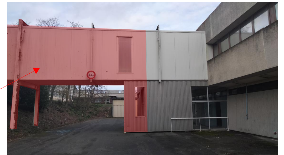
Vue 01 - Passerelle à démolir
