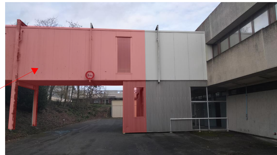
Vue 01 - Passerelle à démolir
