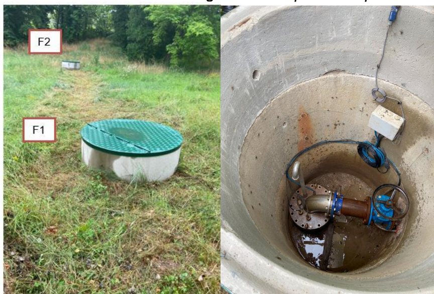
Figure 6 : Cuvelage et tête de puits F2
