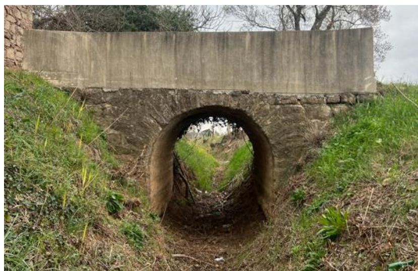
Figure 35 : Vue de l'ouvrage à déconstruire
