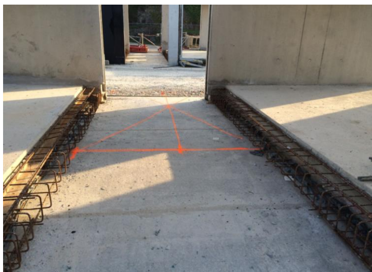
Figure 37 : Armatures en attente en rives de dalle pour la réalisation du clavage
