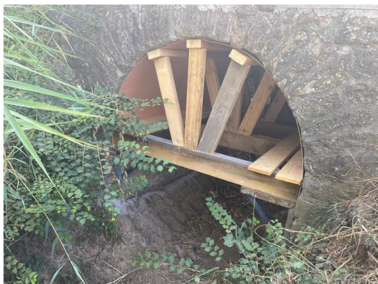
Figure 9 : Etaieement réalisé sur l'ouvrage existant en juillet 2024
