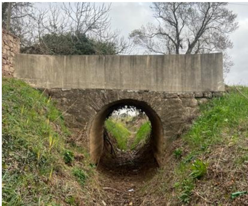
Figure 6 : Vue côté amont
