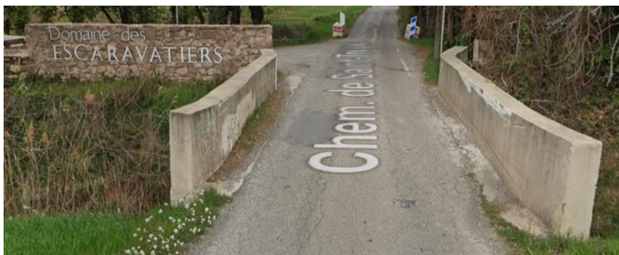
Figure 34 : Mur en briques à conserver et parapets à déconstruire
