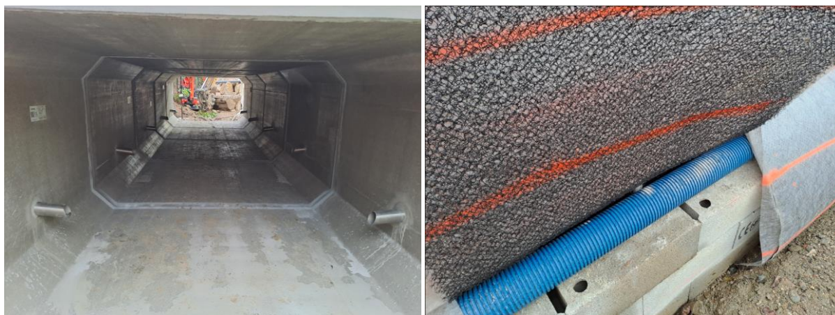
Figure 40 : Pose des équipements de drainage : barbacanes (à gauche) et nappe drainante + drain en pied (à droite)
