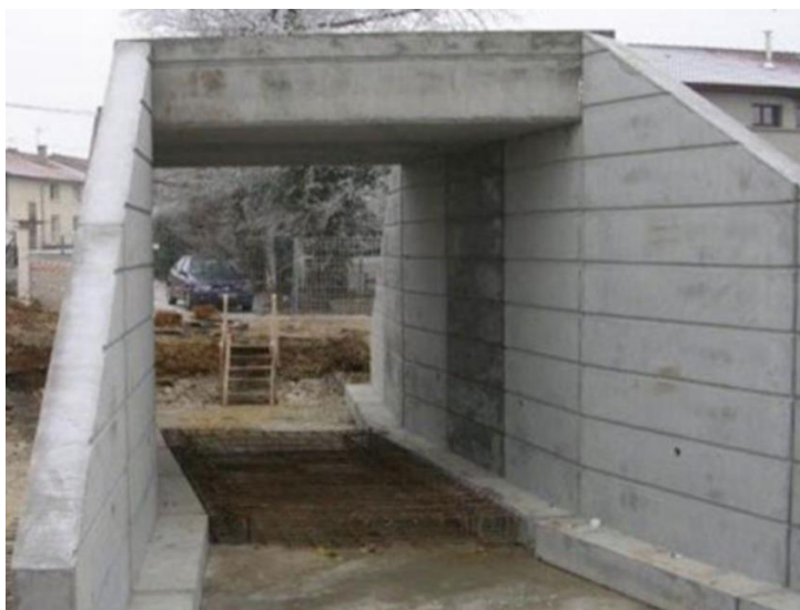
Figure 38 : Pose du ferrailage du radier d'un cadre fermé
