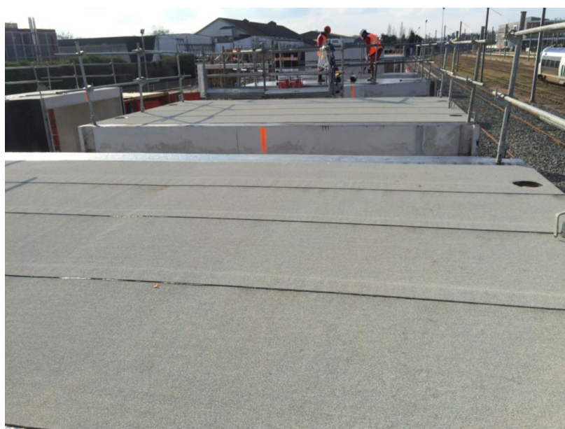
Figure 39 : Pose d'étanchéité par feuilles préfabriquées sur un cadre
