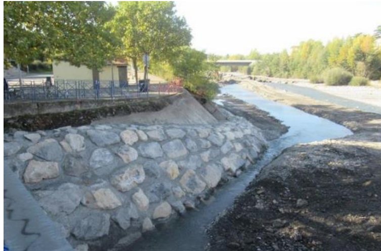
Figure 42 : Exemple de réalisation d'enrochements bétonnés
