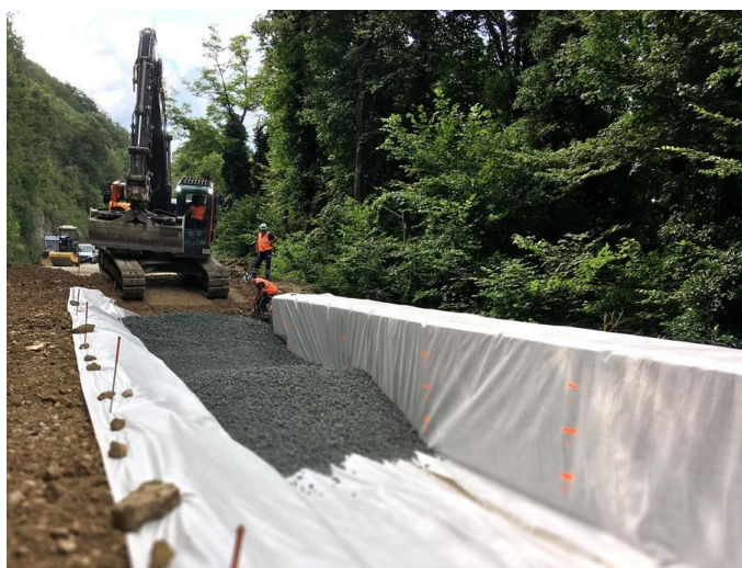
Figure 41 : Phase de remblaiement
