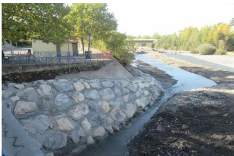
Figure 24 : Exemple de réalisation d'enrochements bétonnés
