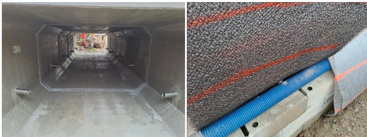
Figure 22 : Pose des équipements de drainage : barbacanes (à gauche) et nappe drainante + drain en pied (à droite)
