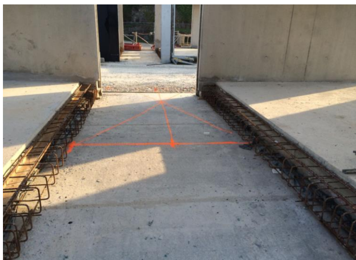
Figure 19 : Armatures en attente en rives de dalle pour la réalisation du clavage
