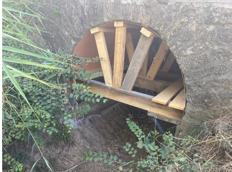
Figure 11 : Étaielement réalisé sur l'ouvrage existant en juillet 2024 (source : PCM GC&OA)
