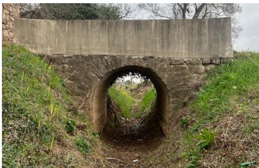
Figure 17 : Vue de l'ouvrage à déconstruire
