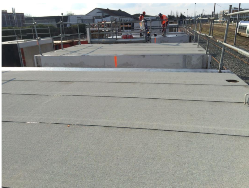
Figure 21 : Pose d'étanchéité par feuilles préfabriquées sur un cadre
