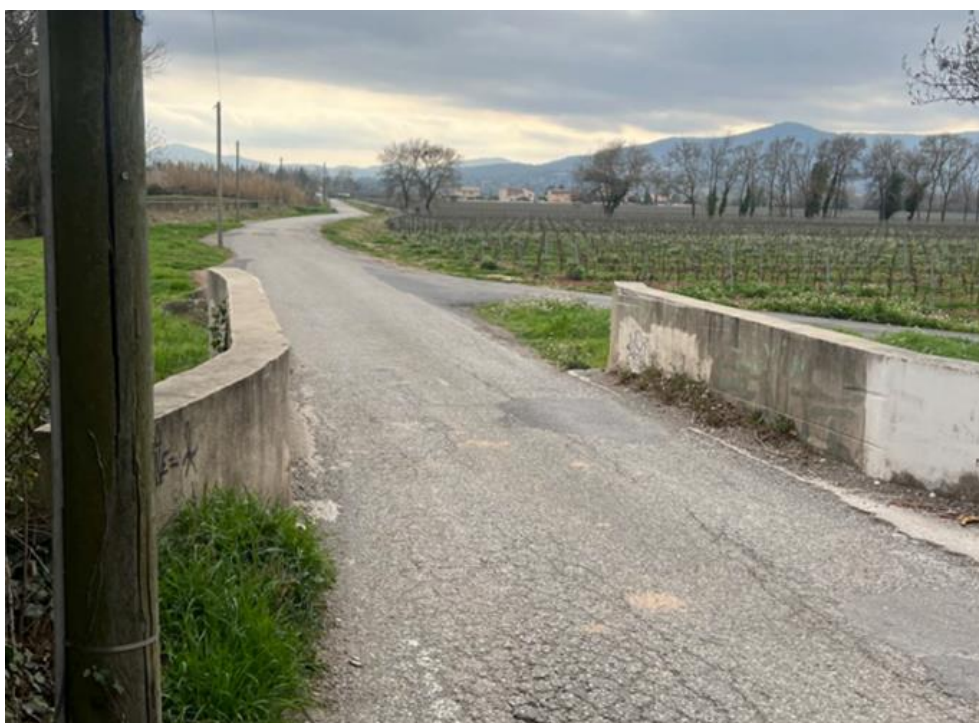
Figure 4 : Photographie du pont du chemin de Saint-Tropez (source : Rapport d'inspection BEMS)
