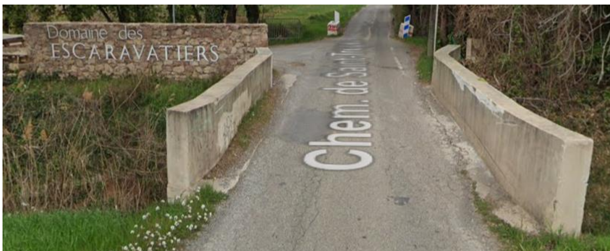
Figure 16 : Mur en briques à conserver et parapets à déconstruire
