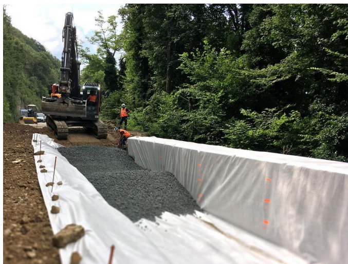
Figure 23 : Phase de remblaiement
