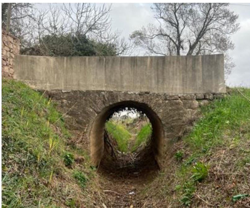
Figure 6 : Photographie de l'ouvrage – Vue côté amont (source : Rapport d'inspection BEMS)
