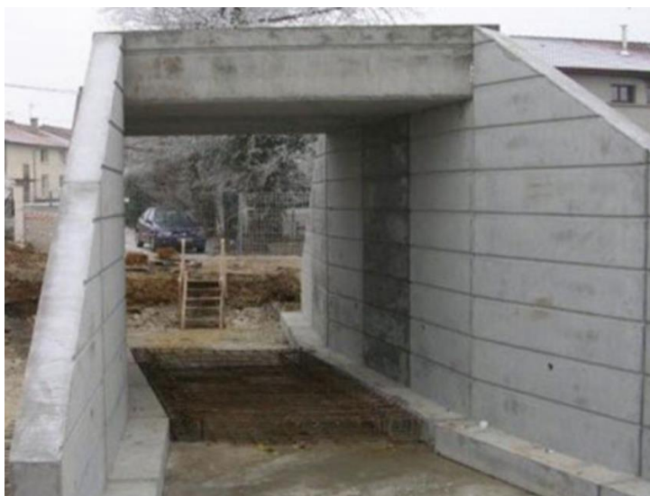
Figure 20 : Pose du ferrailage du radier d'un cadre fermé
