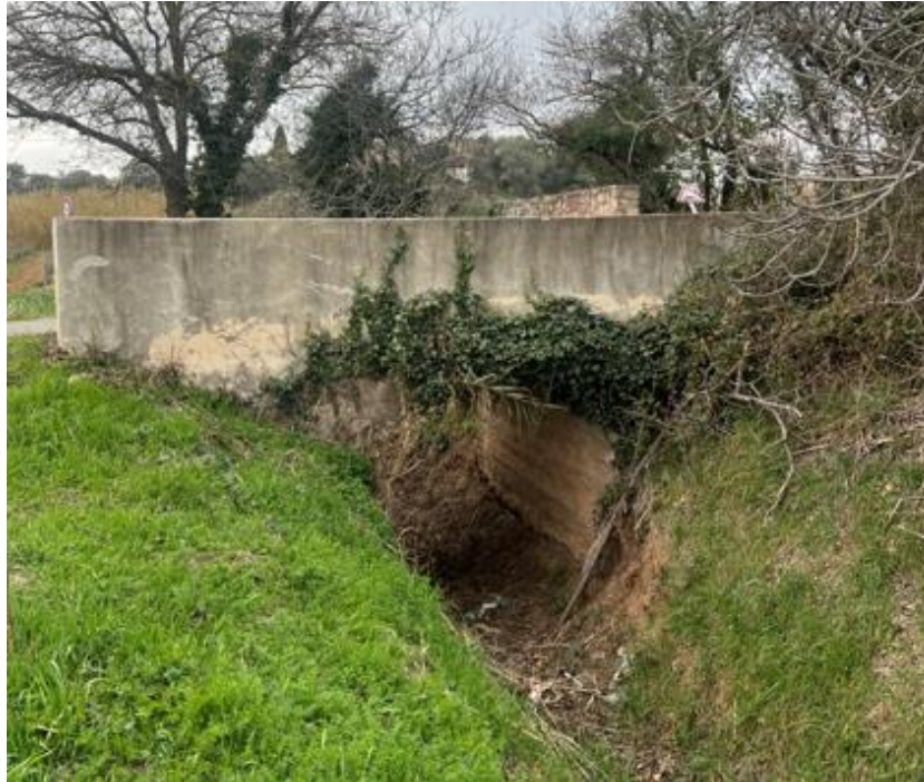
Figure 7 : Photographie de l'ouvrage – Vue côté amont (source : Rapport d'inspection BEMS)
