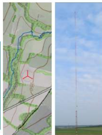
exemple d'un mât de mesure
