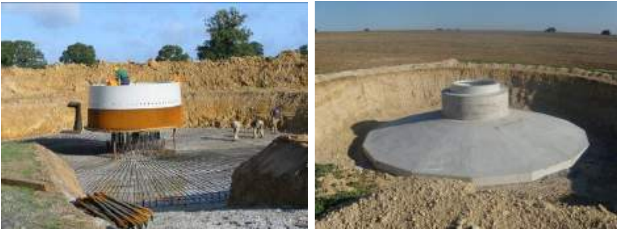
Figure 39 : Le ferrailage et le coulage d’une fondation d’éolienne
