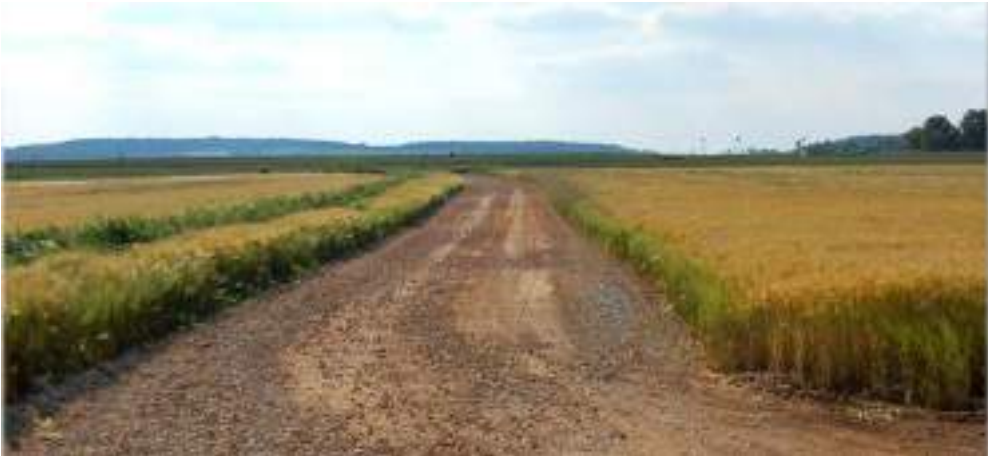
Figure 40 : Exemple de voie d’accès à un parc éolien
