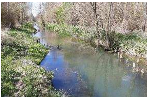
Figure 37 - Epi déflecteur en amont du pont d'Arsonval
