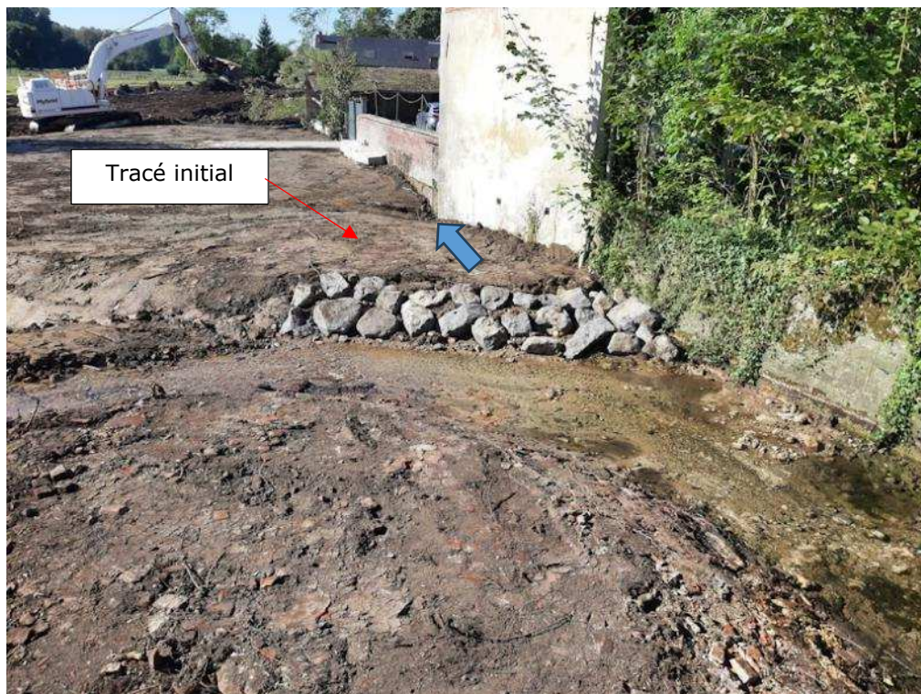
Figure 50 – Photographie en cours de travaux (Le Matz à La Neuville sur Ressons – Dept. 60)
