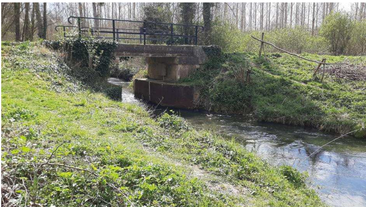
Figure 49 – Photographie du pont d'Arsonval
