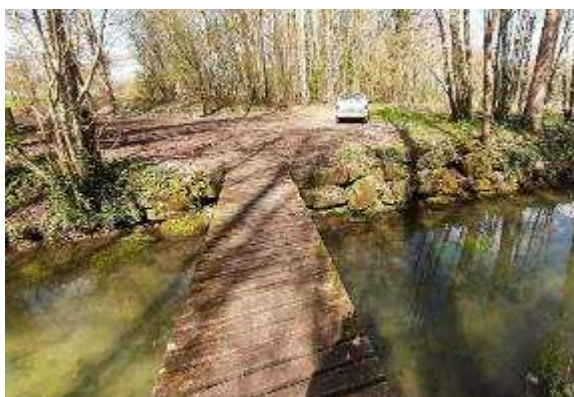
Figure 36 - Renforcement de berges en rive gauche sur l'Aronde
