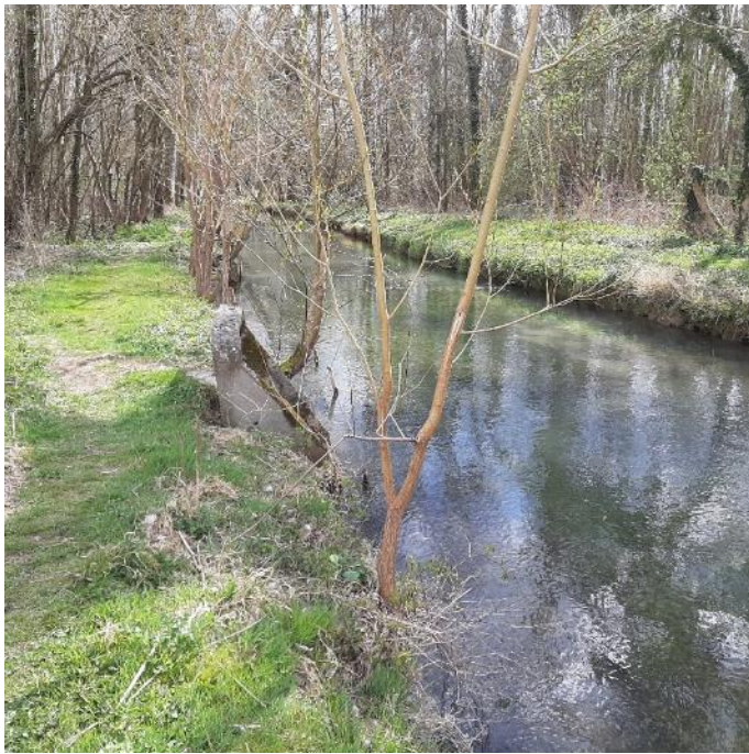
Figure 54 – Photographie de la buse Ø1000 présente en amont du tronçon
