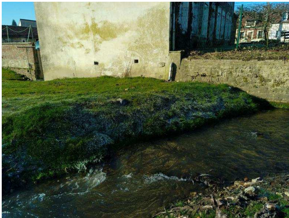
Figure 51 – Photographie après ensemencement de la terre végétale au droit de la protection de berge (Le Matz à La Neuville sur Ressons – Dept. 60)
