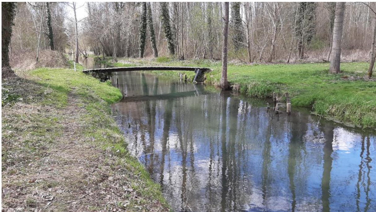
Figure 48 – Photographie de la passerelle de la zone amont
