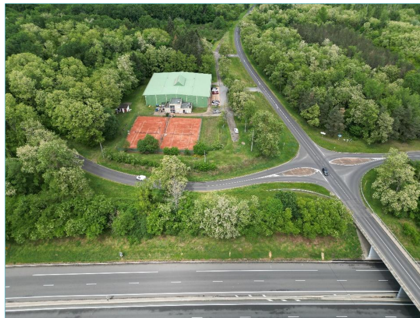
Prise de vue aérienne du secteur vers le Nord et la bande concernée par la présente étude dérogatoire - ©Campus Développement - 2026
