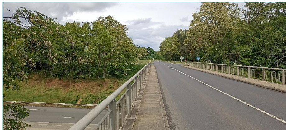
Vue depuis le pont traversant l'autoroute en direction du site du projet - @Campus Développement
