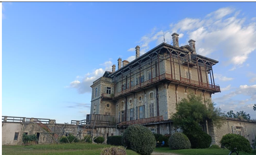
Château d'Ilbarritz (Source : GEOCIAM)
