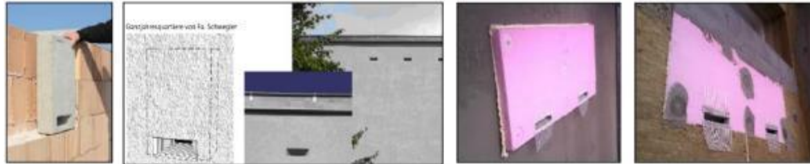
Exemple de niohir intégré ou construit au niveau de la toiture ou du débord de toit (Sources : Joachim Frömer)
