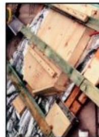
Exemple de niohir intégré ou construit au niveau de la toiture ou du débord de toit (Sources : Joachim Frömer)
