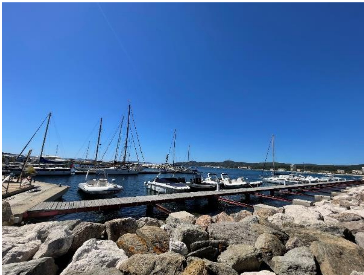
Photographie 2 Vue du ponton flottant à remplacer
