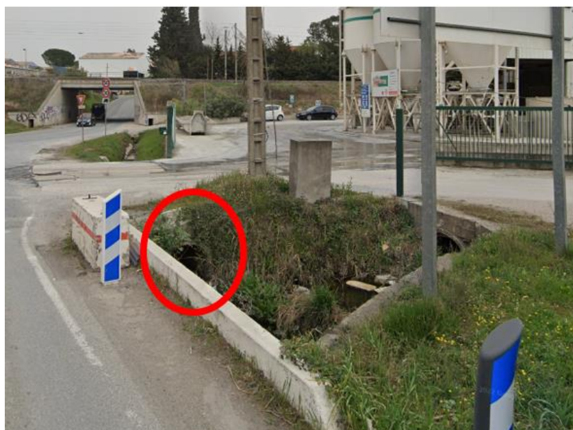
Figure 43 : Réseau pluvial en aval
