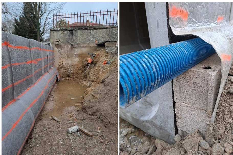
Figure 18 : Pose de nappe drainante et de drain en pied
