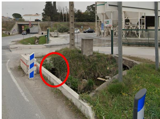
Figure 21 : Réseau pluvial en aval
