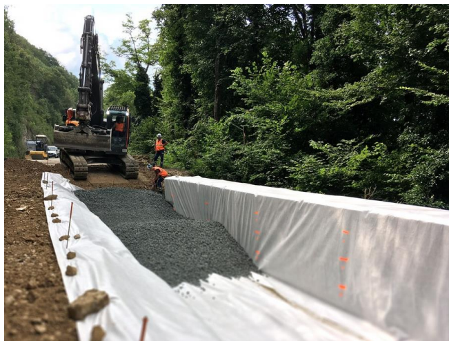
Figure 19 : Phase de remblaiement
