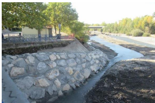
Figure 20 : Exemple de réalisation d'enrochements bétonnés
