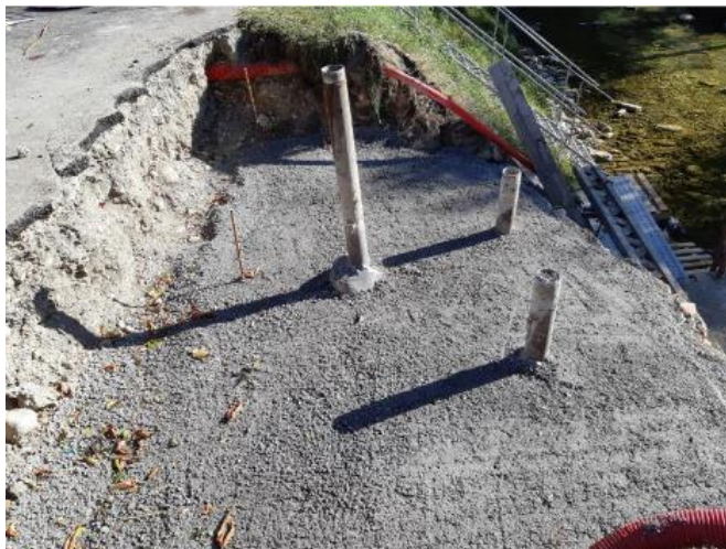
Figure 15 : Têtes de micropieux et béton de propreté
