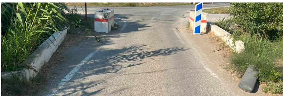
Figure 12 : Longrines à déconstruire
