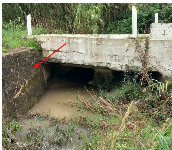
Figure 22 : Mur existant en aval rive droite
