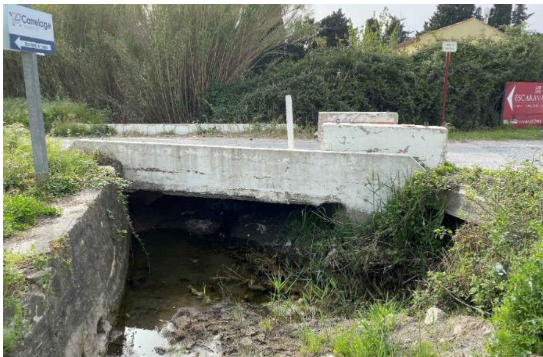
Figure 7 : Photographie de l'ouvrage – Vue côté aval (source : Rapport d'inspection BEMS)
