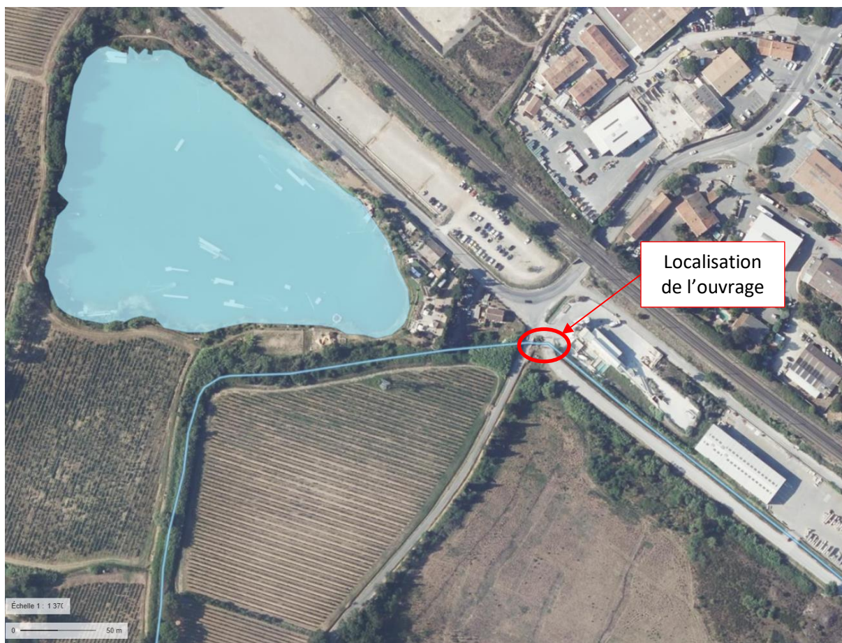
Figure 2 : Vue aérienne de la zone de projet (Source : Géoportail)
