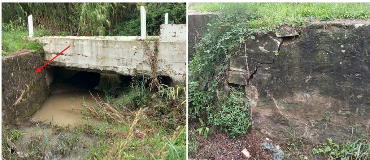
Figure 14 : Murs de protection des berges
