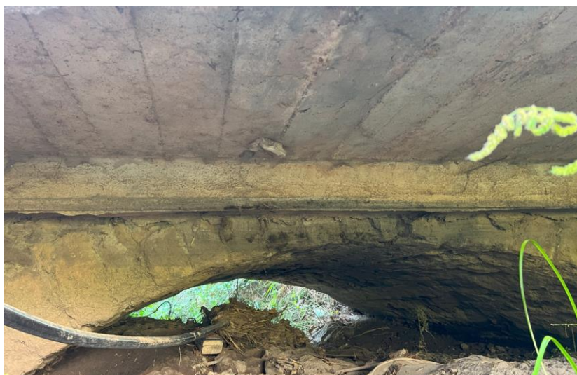
Figure 13 : Vue du dessous du tablier – voûte maçonnée
