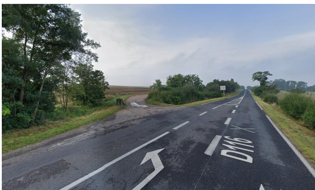
Vue n°1 : vue depuis l'entrée de la voie d'accès (Google Maps, aout 2021)
