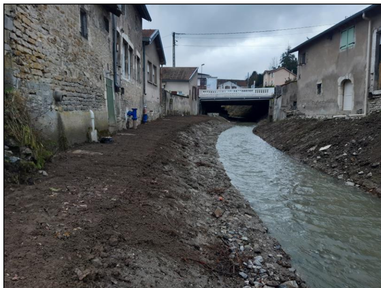
Figure 38 : Poste de pompage en aval du pont de la Poste
