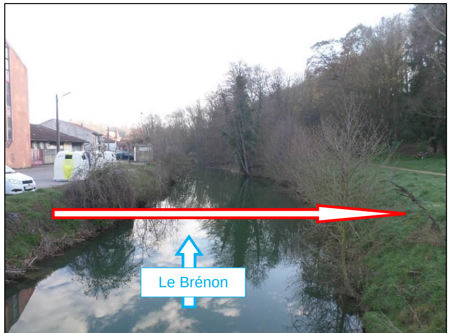
Figure 53 : Localisation du forage sous le Brénon
