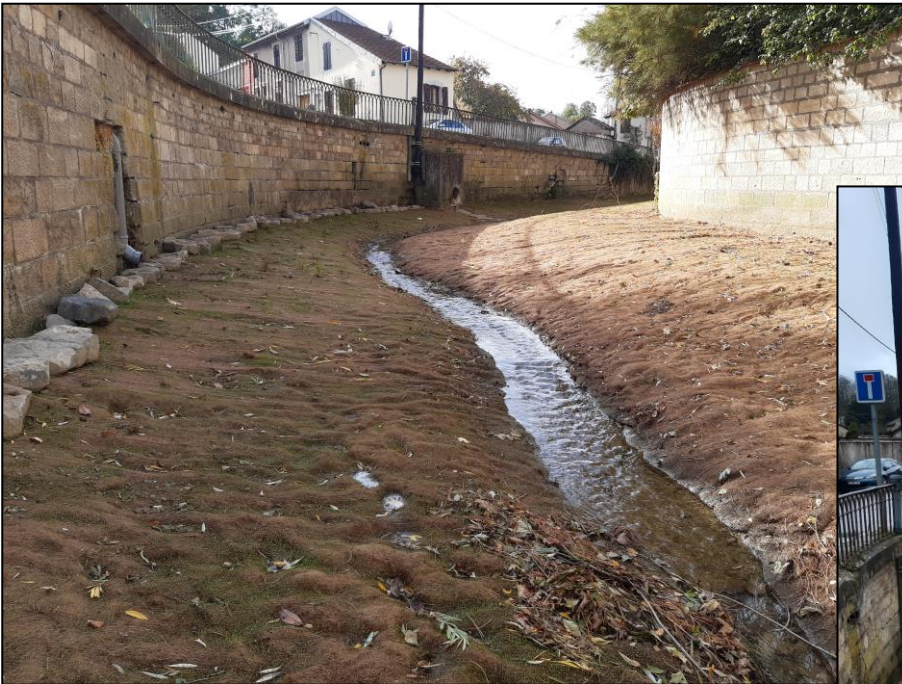
Après travaux – période d'étiage
