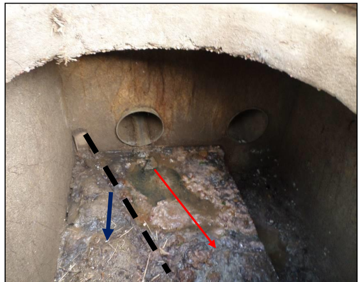
Figure 9 : Déversement permanent vers le milieu
