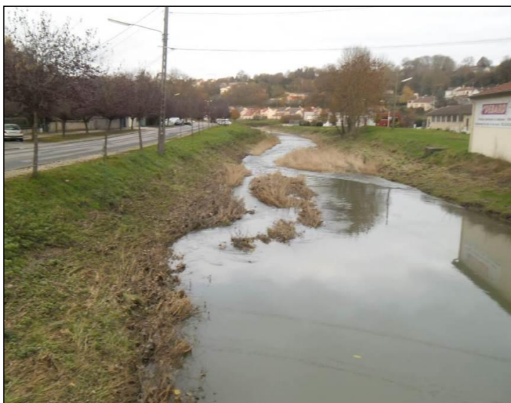
Figure 69 : Le Brénon en aval du centre bourg
