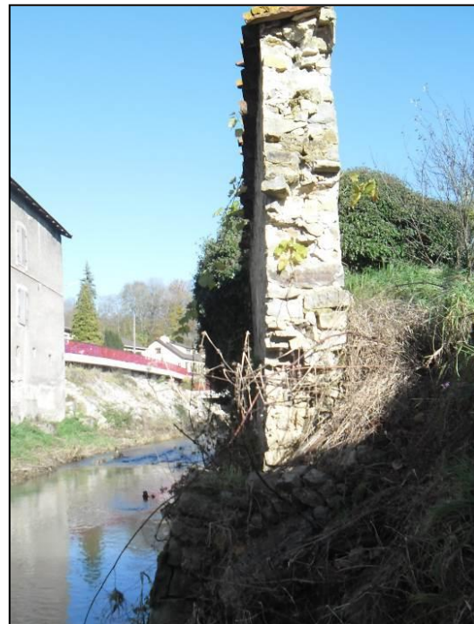
Figure 37 : Murs de soutènement coté Uvry en situation avant travaux
