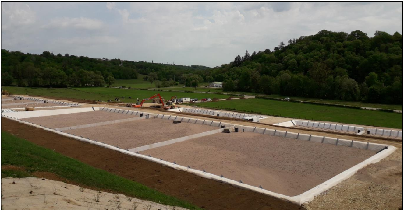
Figure 34 : Ouvrage en cours de finalisation
