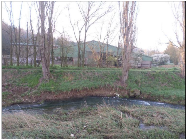
Figure 63 : Encoche d'érosion Rive droite avec plantation de peupliers
