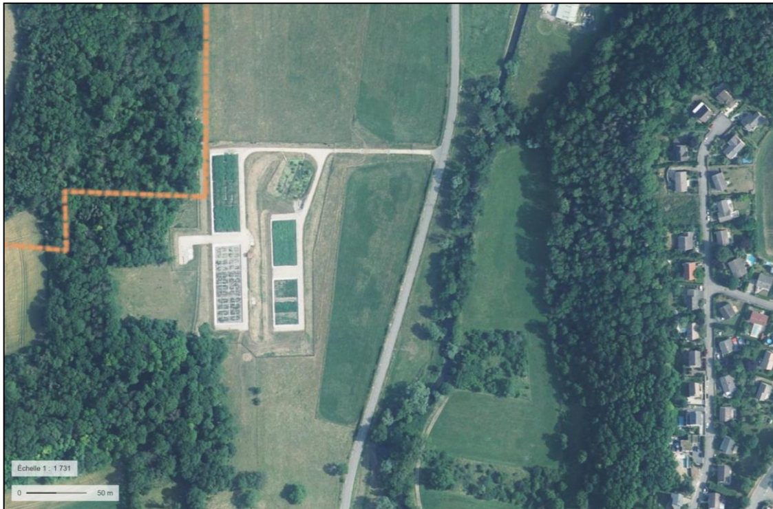
Figure 33 : Vue aérienne de l'ouvrage
