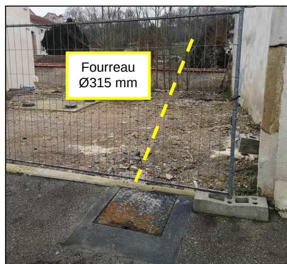
Figure 47 : Parcelle privée Rue Foch : tracé du fourreau posé
