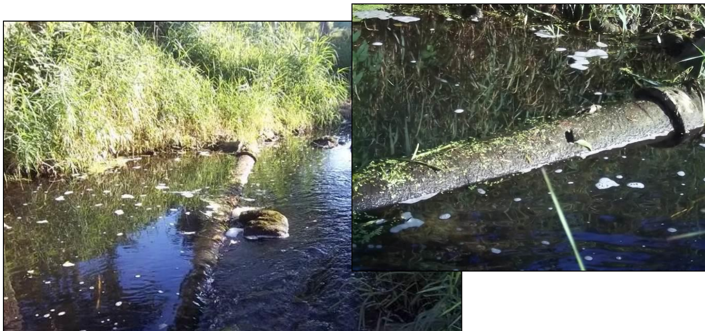
Figure 4 : Réseaux dans le cours d'eau en aval de la commune (au droit du lotissement « Moutoilles d'Argent »)
