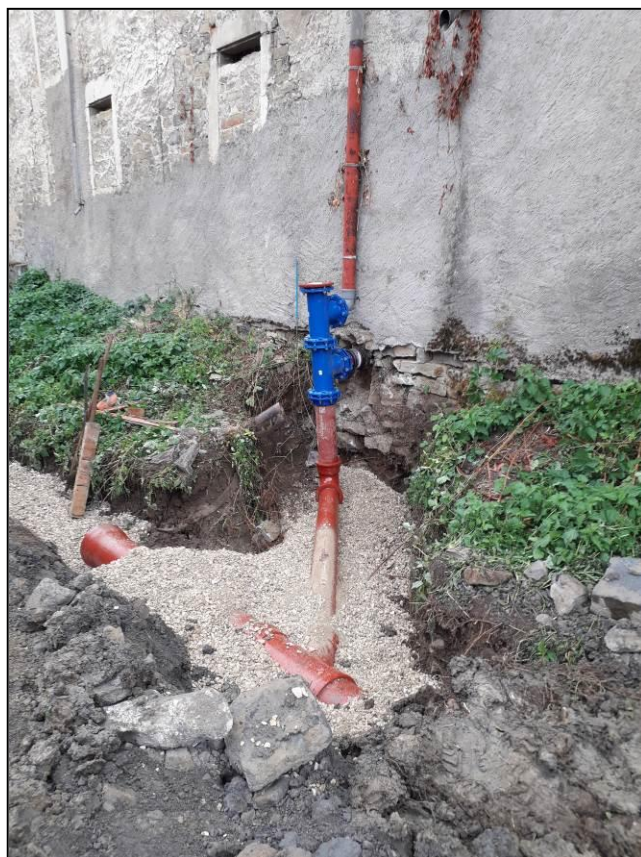
Figure 36 : Exemple de ligne principale avec branchement
