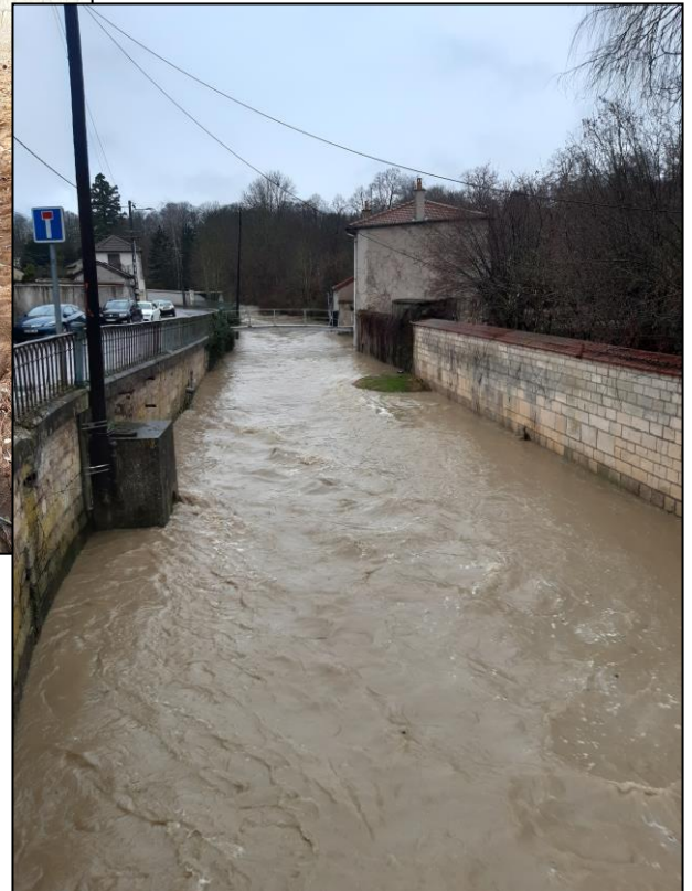
Figure 39 : Travaux réalisés dans l'Uvry – tronçon Uvry « amont »
