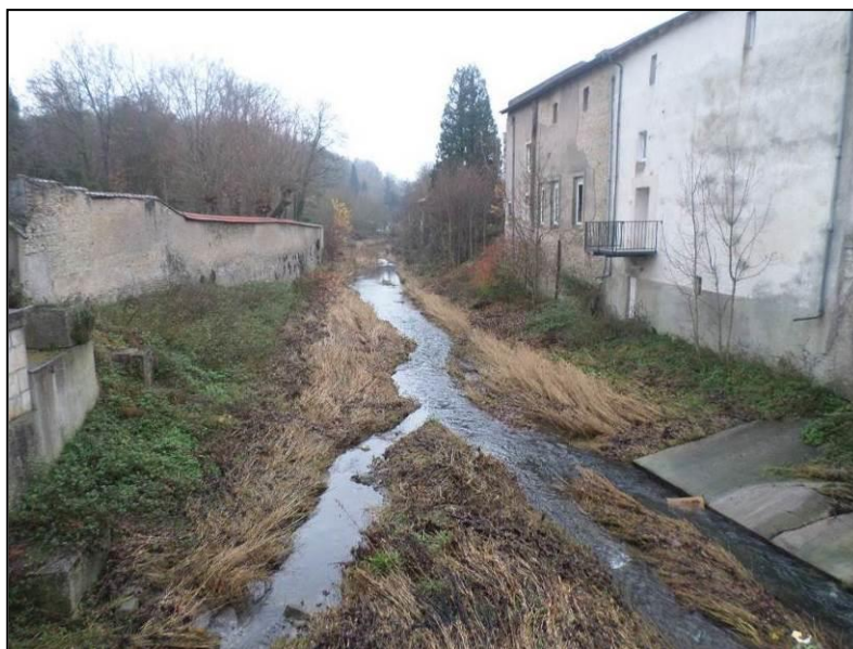
Figure 68 : Brénon en aval du pont de la Rue Foch
