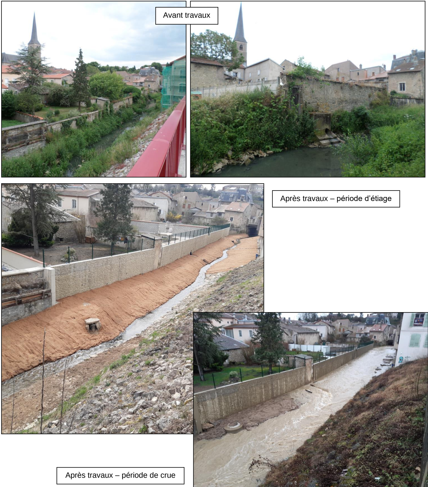
Figure 41 : Travaux réalisés dans l'Uvry – tronçon central
