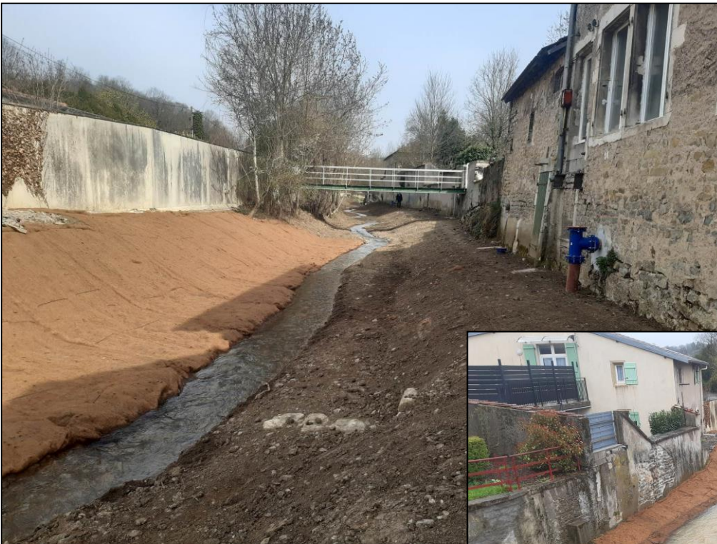
Après travaux – période d'étiage
