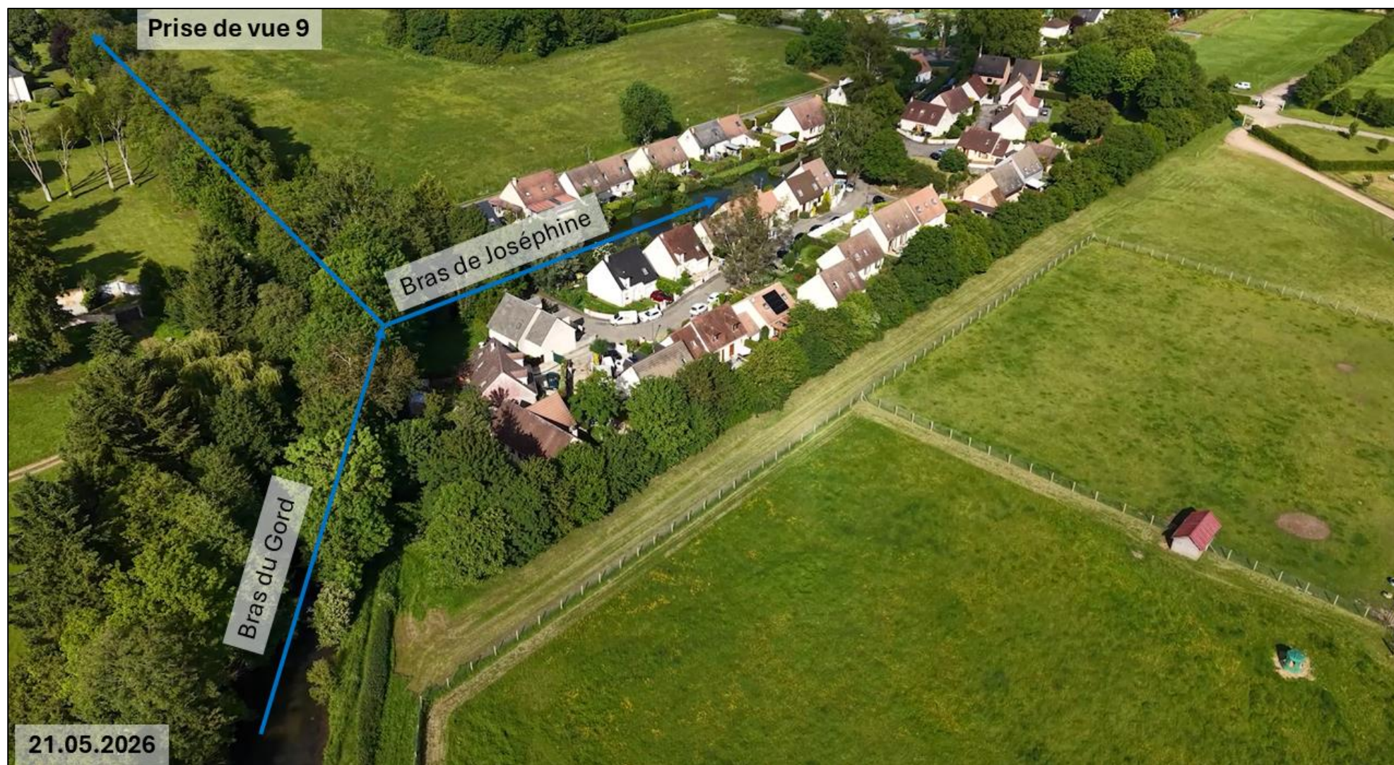
Figure 12 : Photographie n°9 – Vue aérienne du tronçon 2 et tronçon 3
