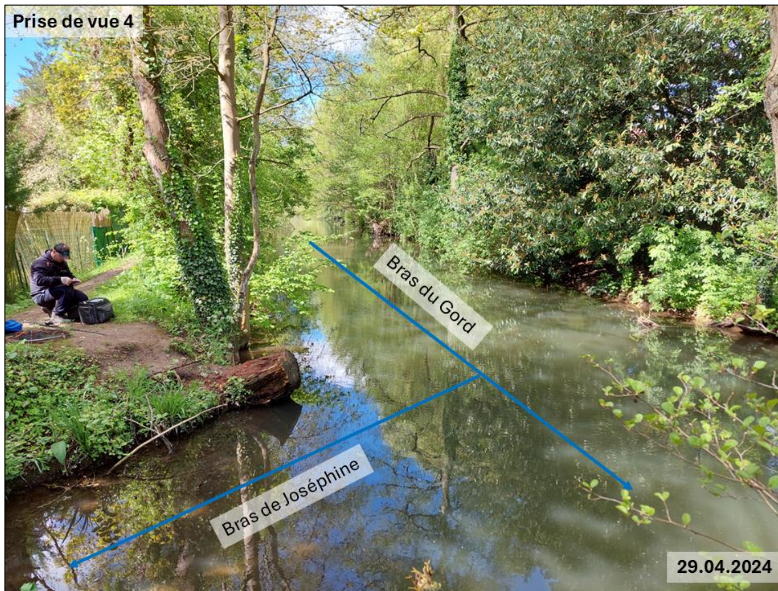
Figure 7 : Photographie n°4 – Vue vers l'amont de l'amont du tronçon 2 et la défluence du bras du Gord vers le bras de Joséphine et la vannette du Domaine
