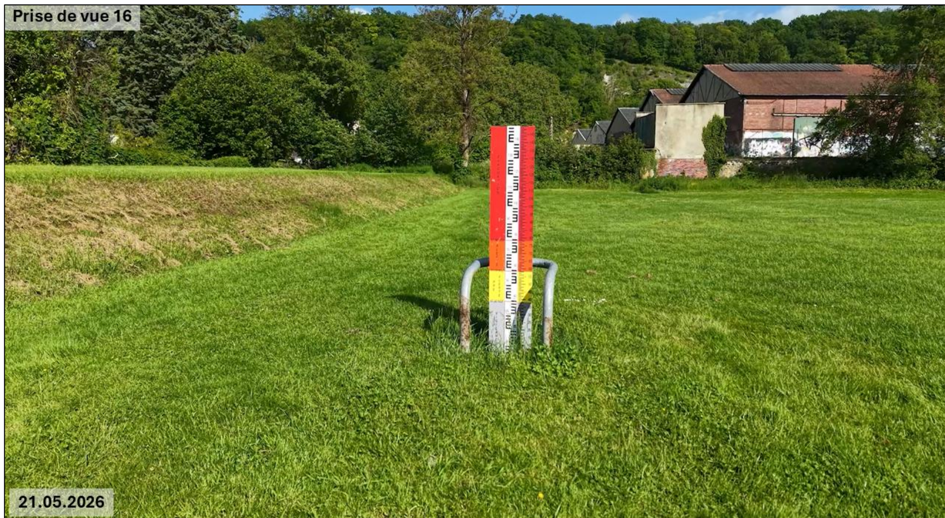
Figure 19 : Photographie n°16 – Vue de l'échelle limnimétrique en amont de la digue Est
