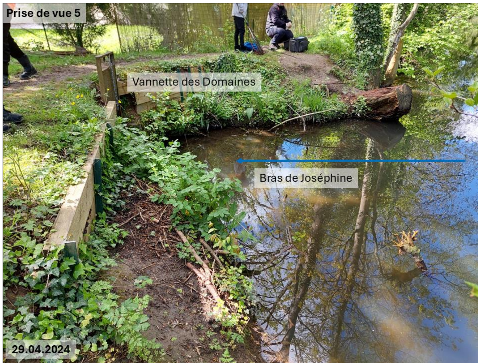
Figure 8 : Photographie n°5 – Vue de l'entrée du bras de Joséphine et la vannette du Domaine
