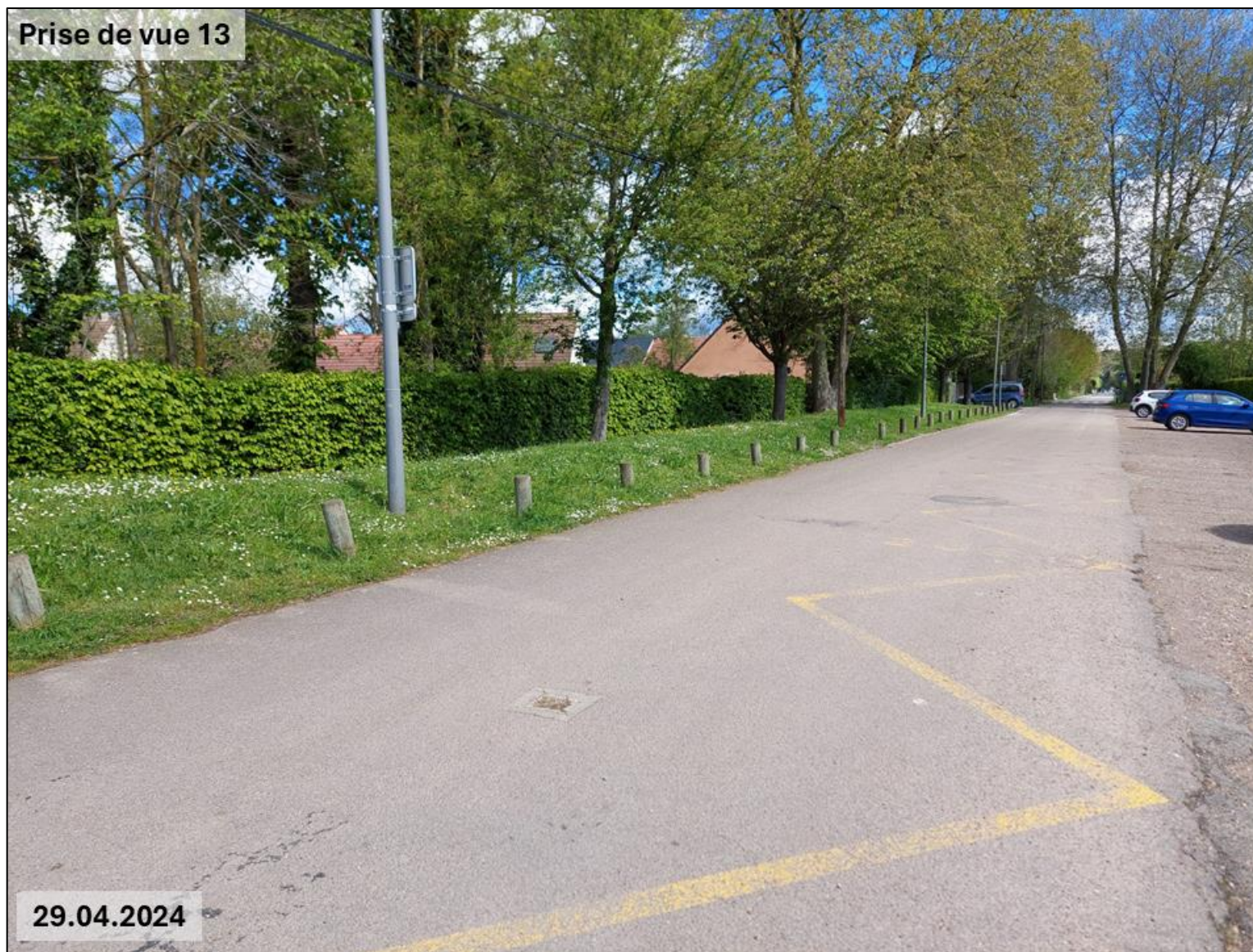
Figure 16 : Photographie n°13 – Vue du merlon de la digue Ouest longeant la rue des Marronniers
