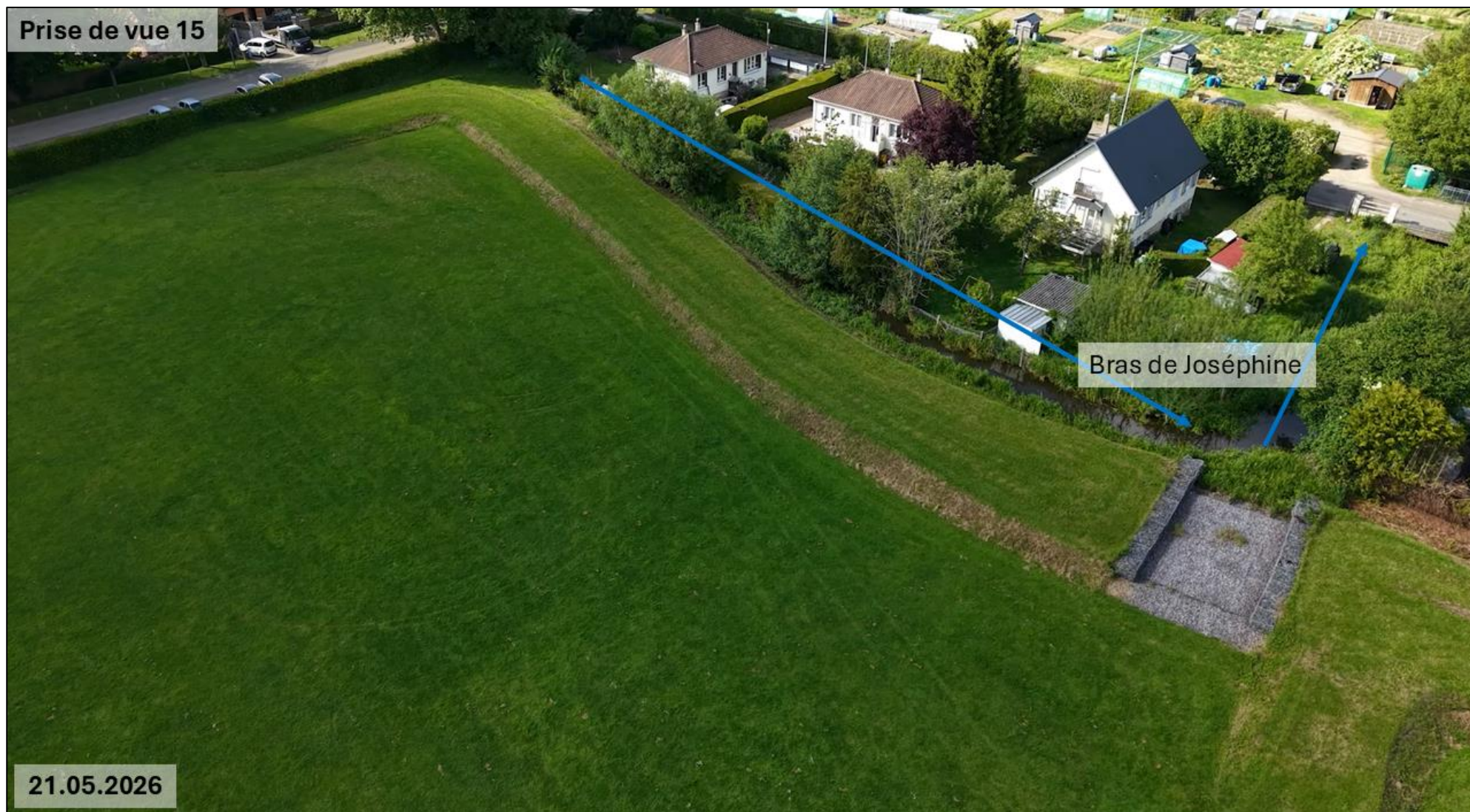
Figure 18 : Photographie n°15 – Vue aérienne de la digue Est et son déversoir
