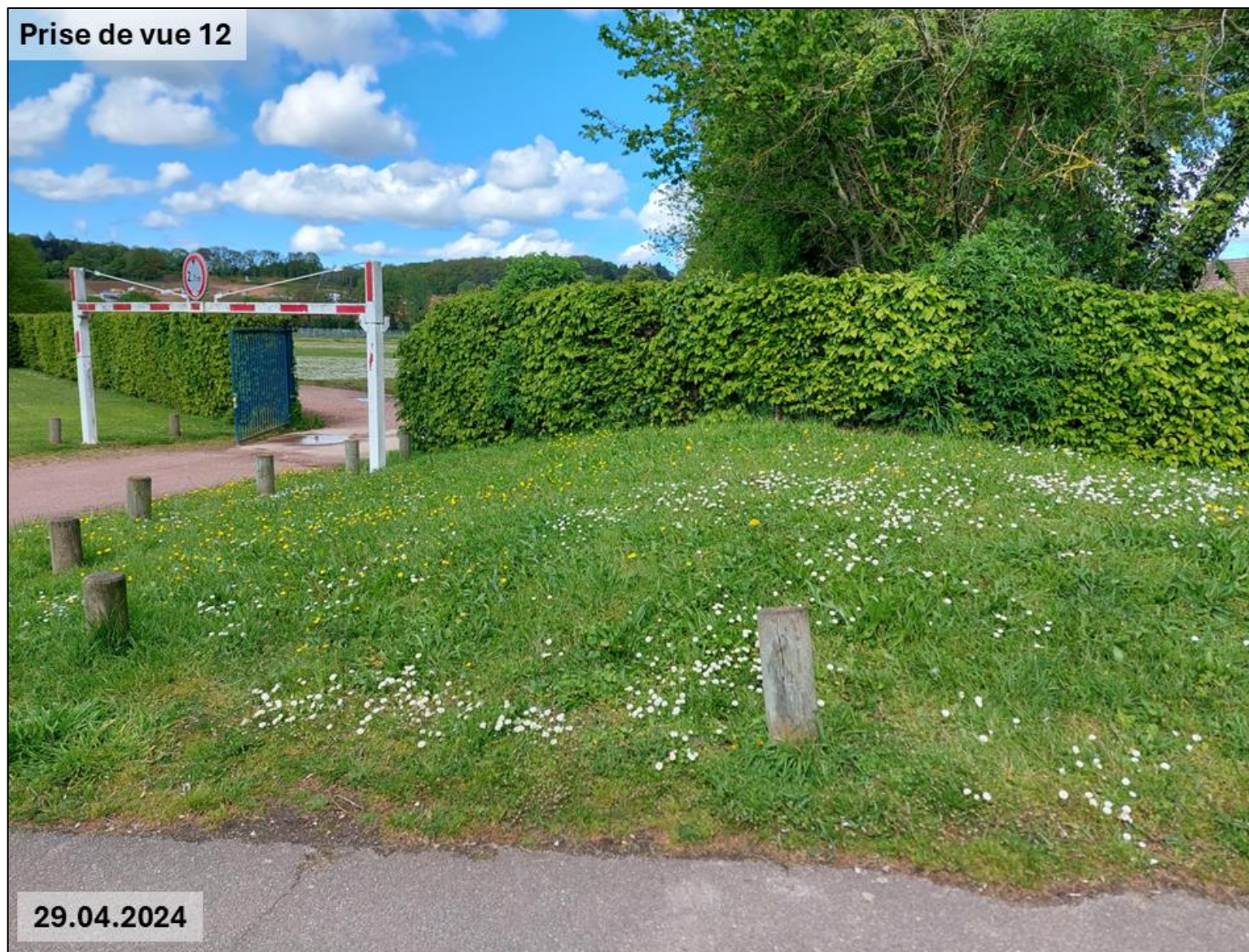
Figure 15 : Photographie n°12 – Vue de la digue Ouest depuis la rue des Marronniers
