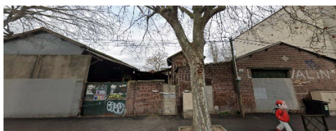
Ancienne chiffonnerie située au niveau du boulevard Marcel Paul
