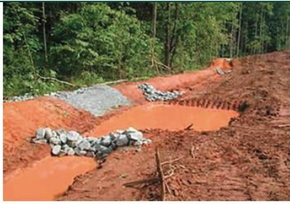
Piège à sédiments positionné en bas de pente avec fosse de récupération des écoulements.
