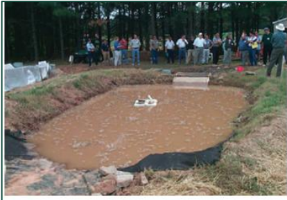
Piège à sédiments avec berges végétalisées.
