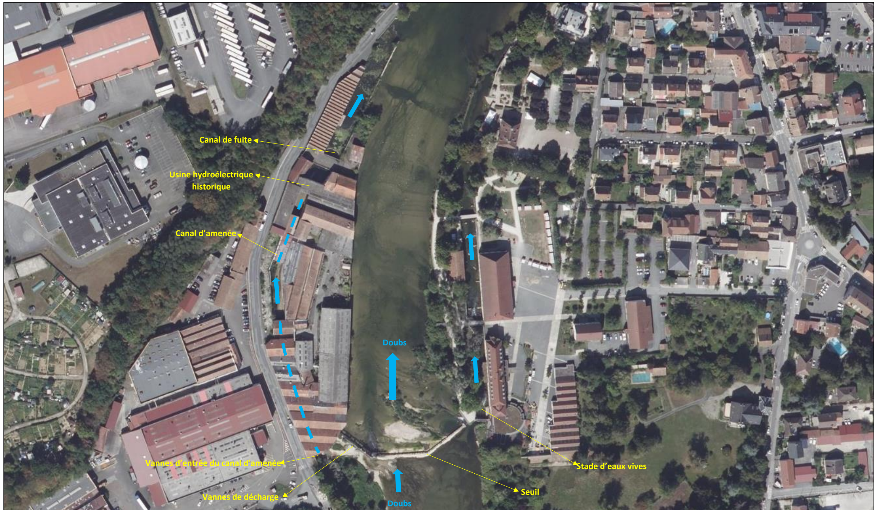
Figure 1 : Présentation du site du projet (vue aérienne)
