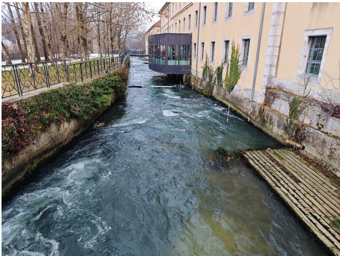
Vue 13 : Le parcours vu de l'amont
