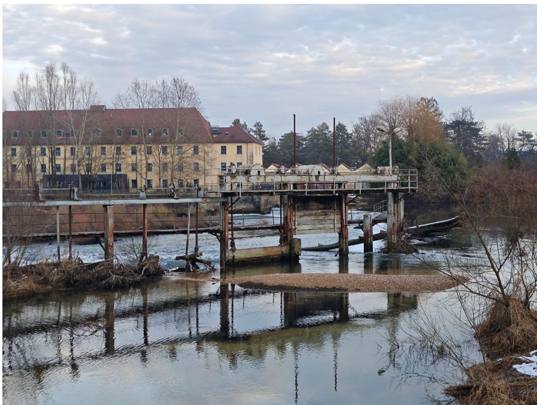
Vue 4 : Les vannes de décharge de crue
