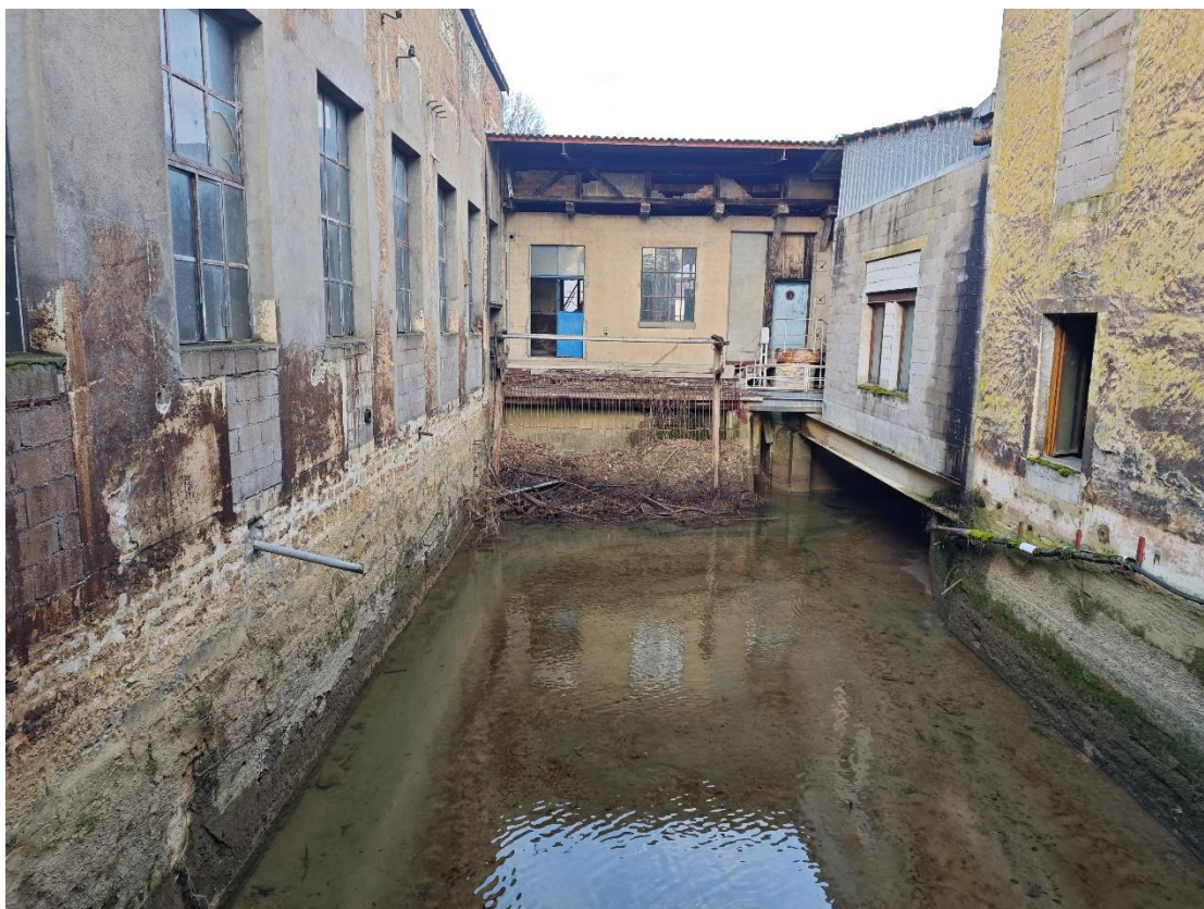
Vue 9 : Vue depuis le canal d'amenée, au fond le dégrilleur et le local technique
