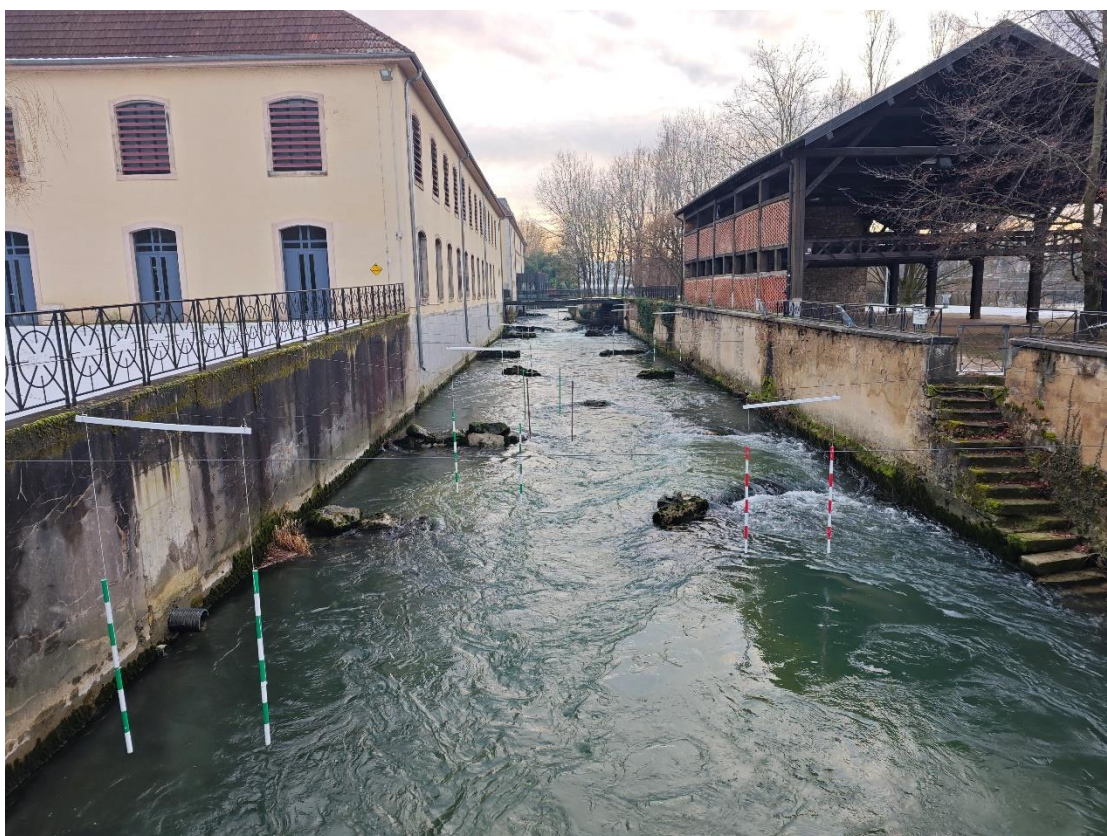
Vue 14 : Le parcours vu de l'aval
