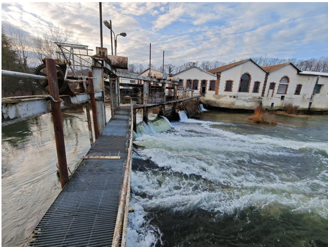
Vue 3 : Les vannes de décharge de crue, les bâtiments
