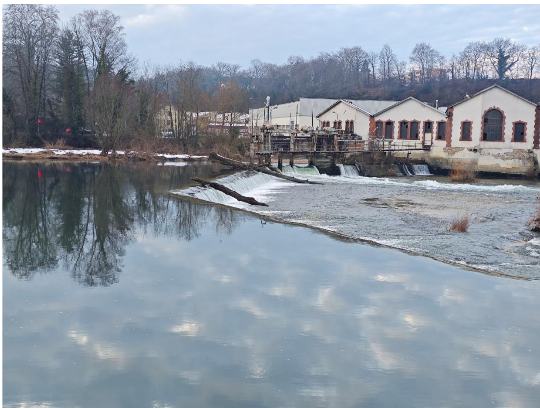
Vue 2 : Le seuil, les vannes de décharge de crue, les bâtiments
