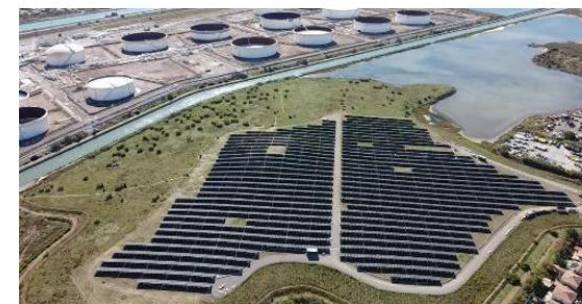
Frontignan (34) – 5MWc Réhabilitation d'une ancienne décharge
