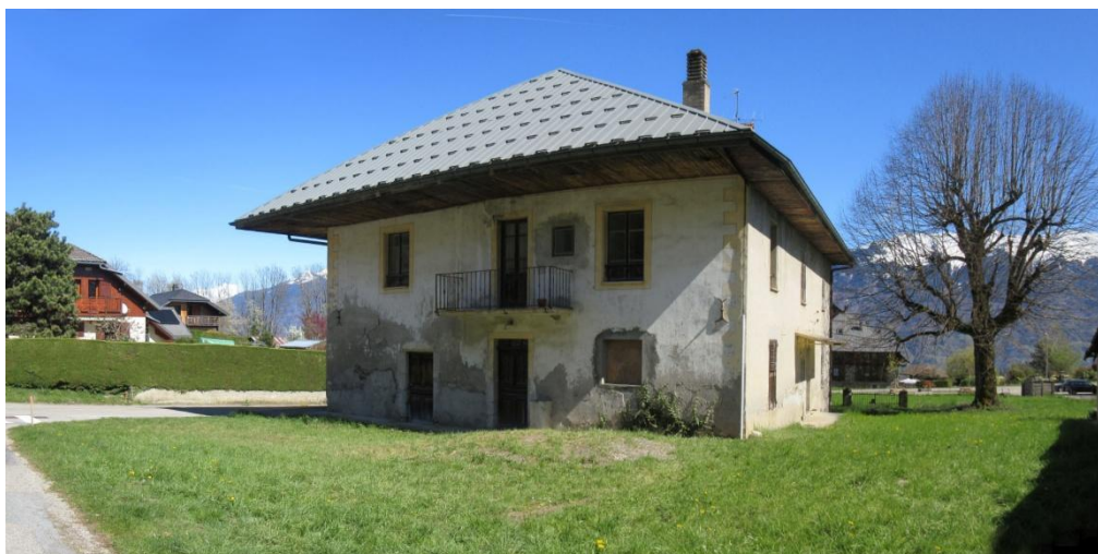
Photo 3 : Façades nord-ouest et sud-ouest
