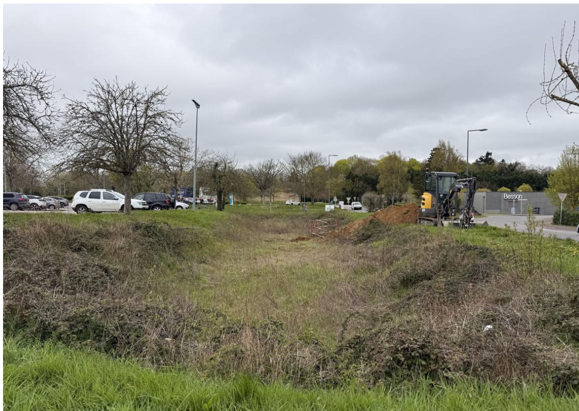
Figure 14 : Bassin de tamponnement (Source : Lapchin Architecte)
