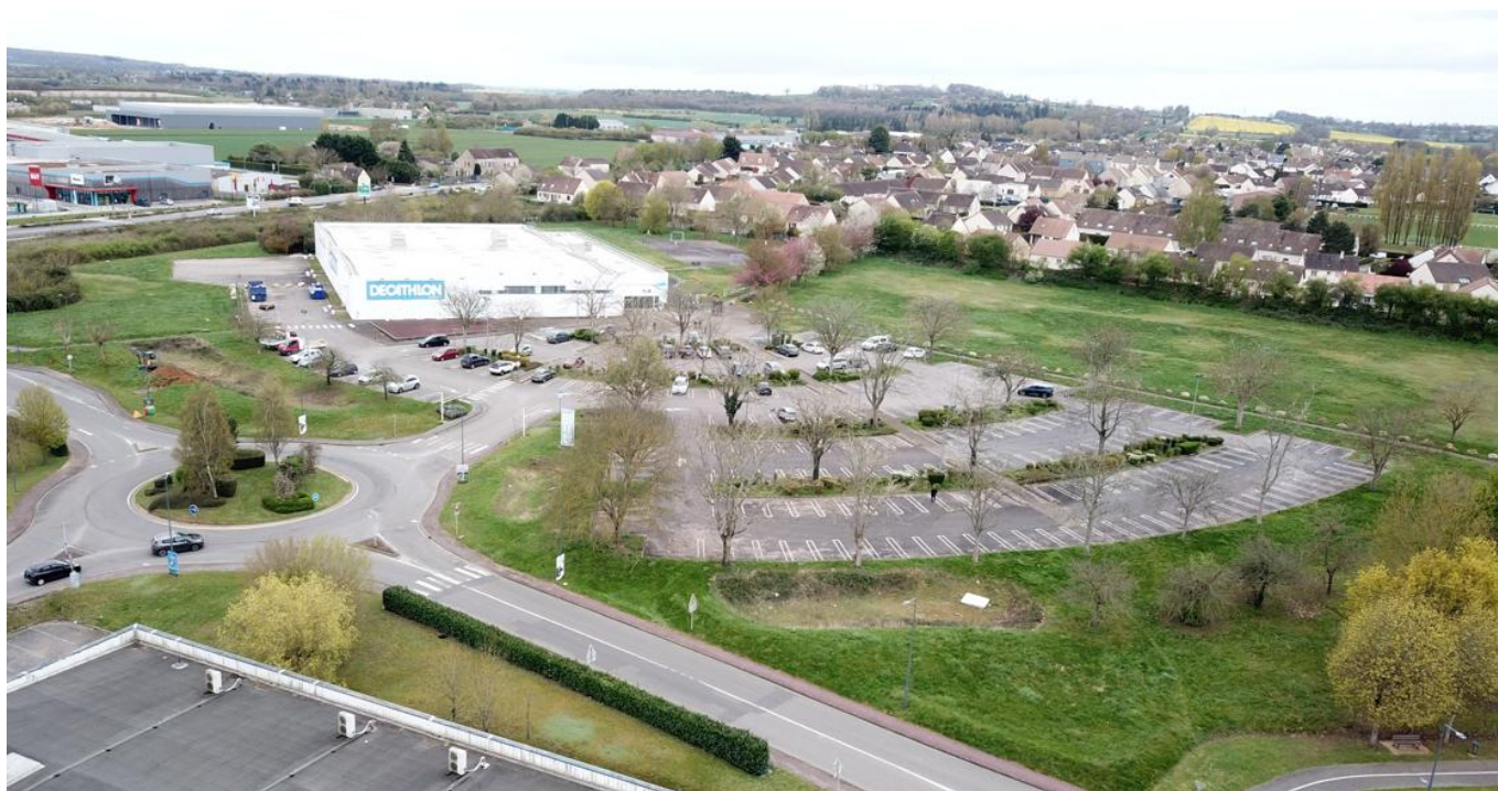
Figure 20 : Vue aérienne du projet (Source : Lapchin Architectes 04/2026)
