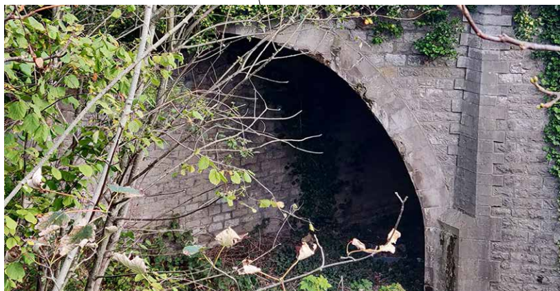
Présence d'ouvrages favorables aux mode doux
