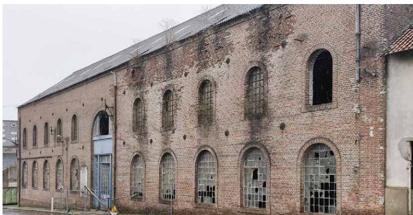
Longères et bâtiments en briques
