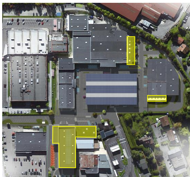
Zone à construire
