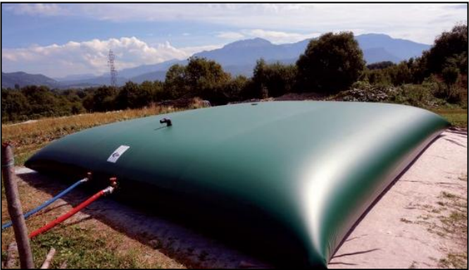
Figure 30: Exemple d'une citerne souple de 120 m³
