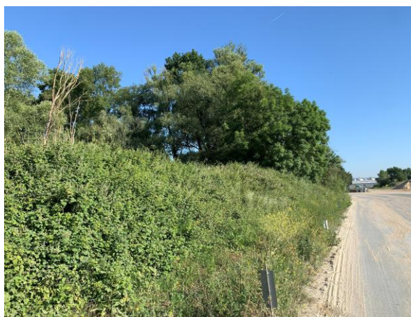
Merlon de terre végétalisé en bord de route devant accueillir la canalisation servant au refoulement vers la Loire
