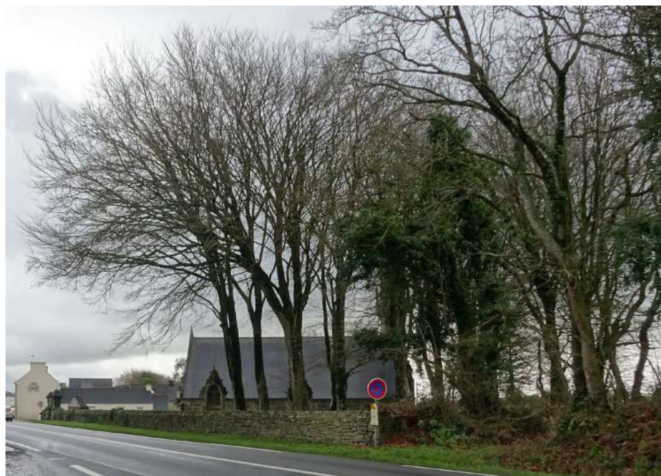
Présences qui occulte partiellement le bâtiment de la Chapelle
