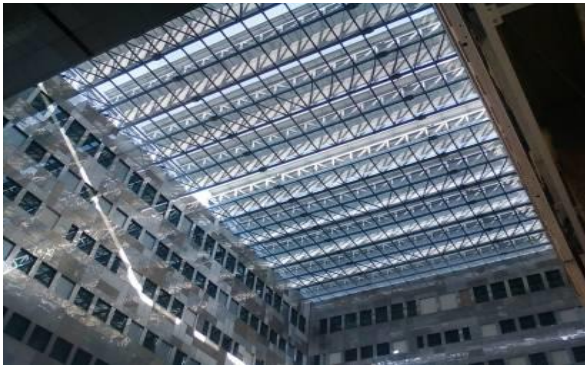
TOITURE MAIRIE DE MONTPELLIER
