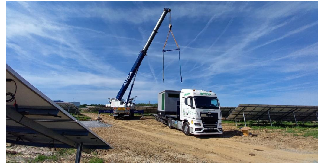
Photo 5 : Installation d'un local technique
