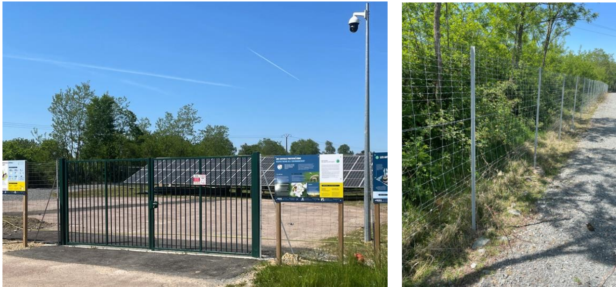
Figure 15 : Photographie d'un portail et d'une clôture
