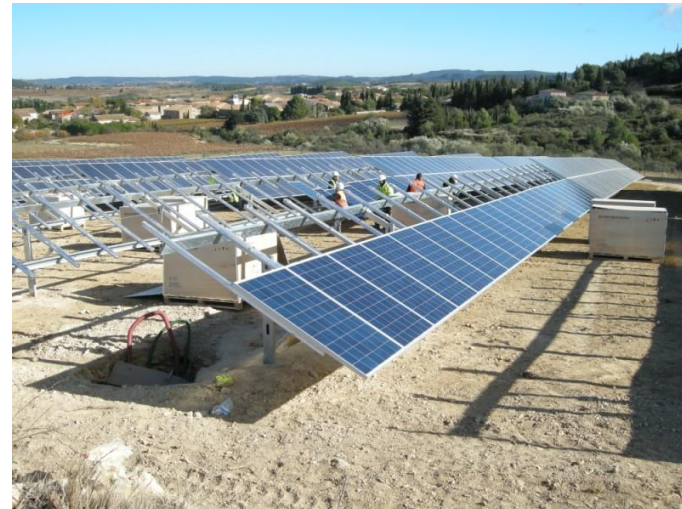
Photo 4 : Montage des modules
