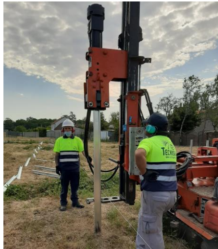
Photo 3 : Installation de pieux battus
