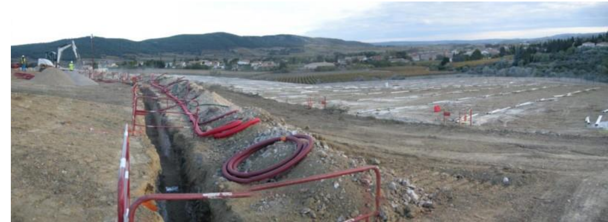
Figure 16 : Travaux de création d'une tranchée
