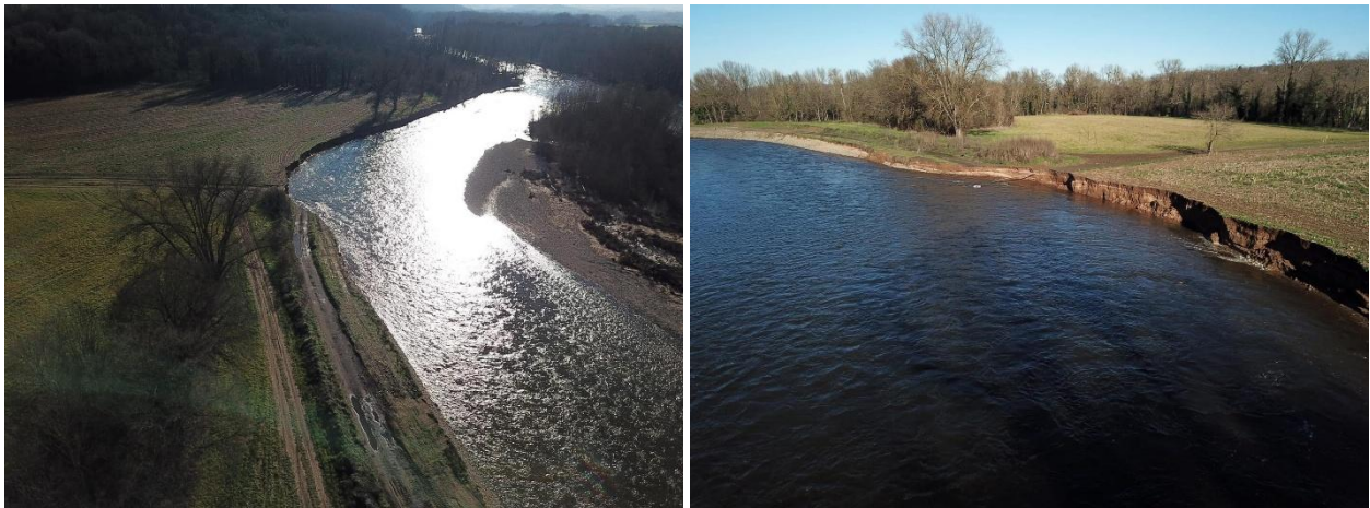
Fig. 10 : Photographies aériennes 2026 de la berge rive droite par drone. Source : Géoval
