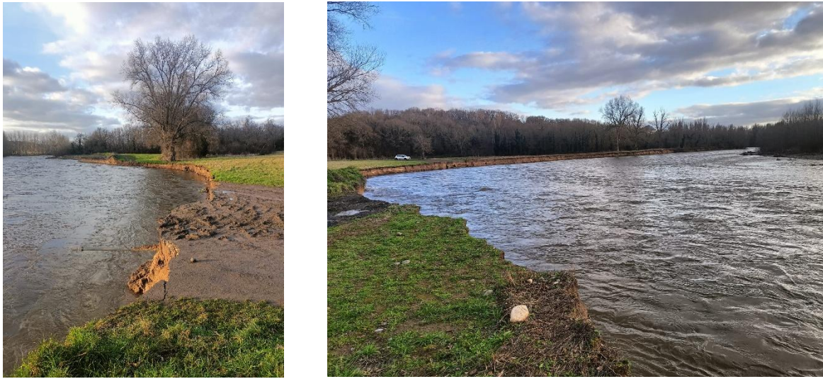
Fig. 7 : Photographies de la canalisation cassée au droit de la rive droite. Source : SME
