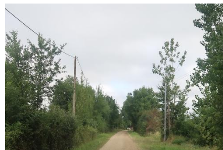
Lignes électriques en bordure du site Source : ARTIFEX 08/2024
