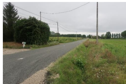
Route départementale D211 et fossé Source : ARTIFEX 08/2024
