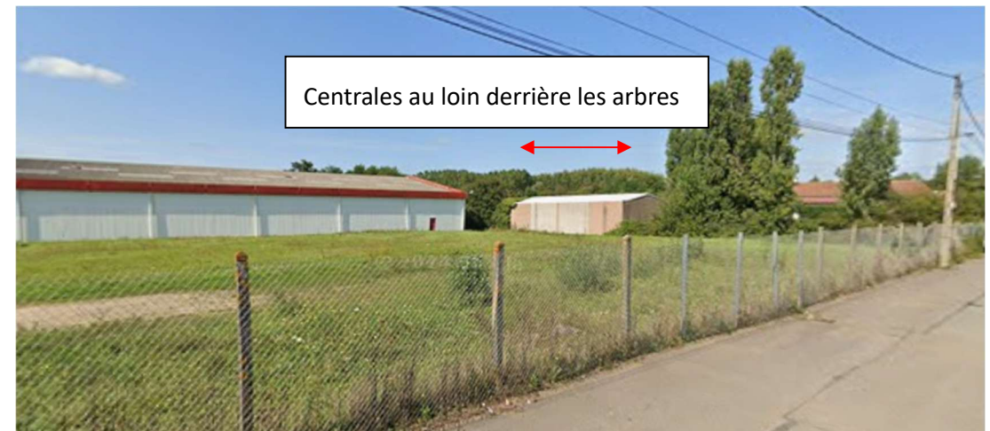
4) Vue depuis la rue Les Brasses, septembre 2024
