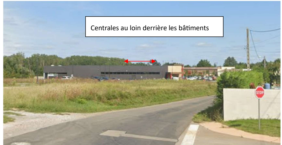
3) Vue depuis la rue Les Etelles, septembre 2024
