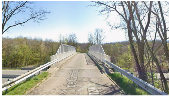
Passage sur l'autoroute en regardant vers le sud. Source : Google Streetview avril 2025
