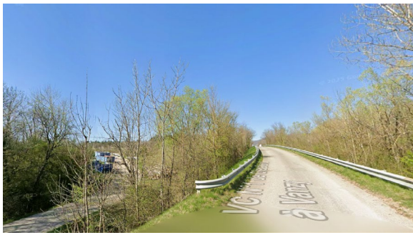
Passage sur l'autoroute en regardant vers le nord. En contre bas à gauche, le site du projet. Source : Google Streetview avril 2025
