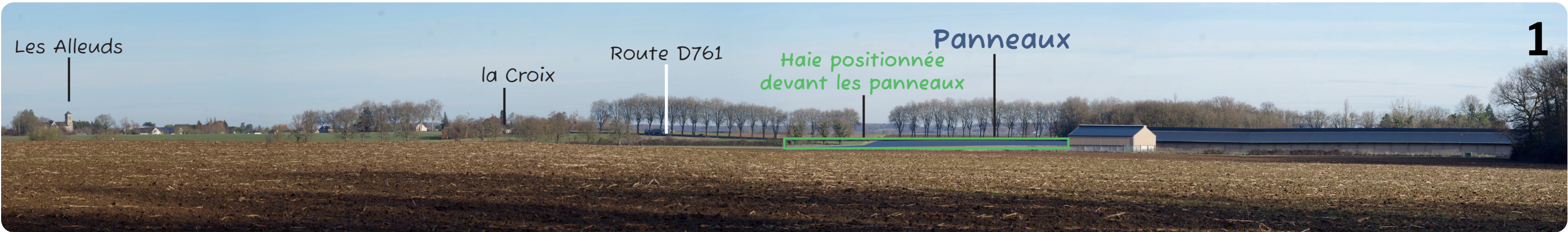
Vue sur le projet depuis un chemin agricole au sud-ouest du projet
