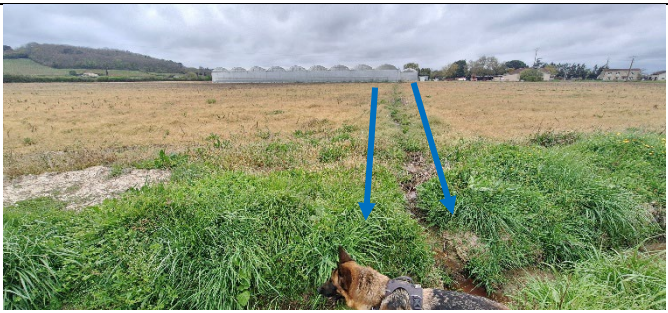
L'écoulement pluvial actuel non dirigé se fait dans ce petit fossé de surface, déjà en direction du fossé de l'impasse.
