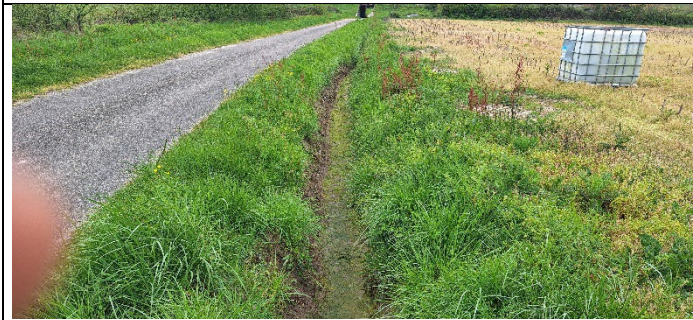
Le Fossé de l'impasse de Bernès : entretenu et de faible section.
