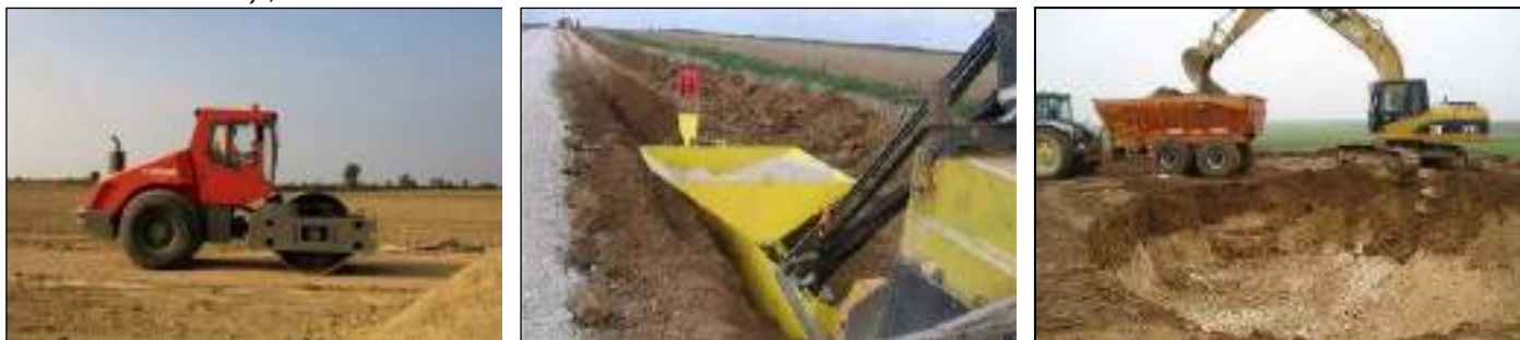
Illustration 2 : Exemples d'incidences sur les sols lors du chantier d'installation d'un parc éolien (aplanissement des terrains, creusement des tranchées de raccordement et excavation des fouilles nécessaire à la mise en place de fondations)
