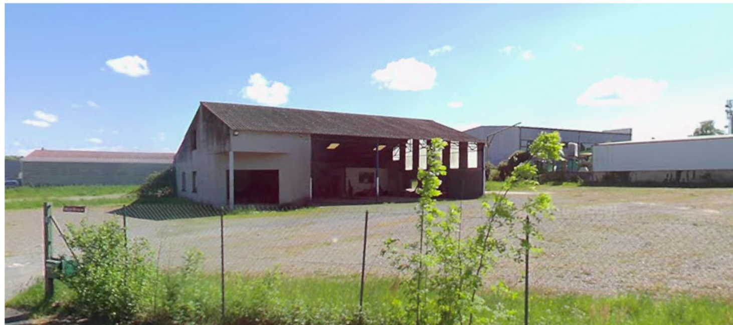
H) Vue sur bâtiment existant
