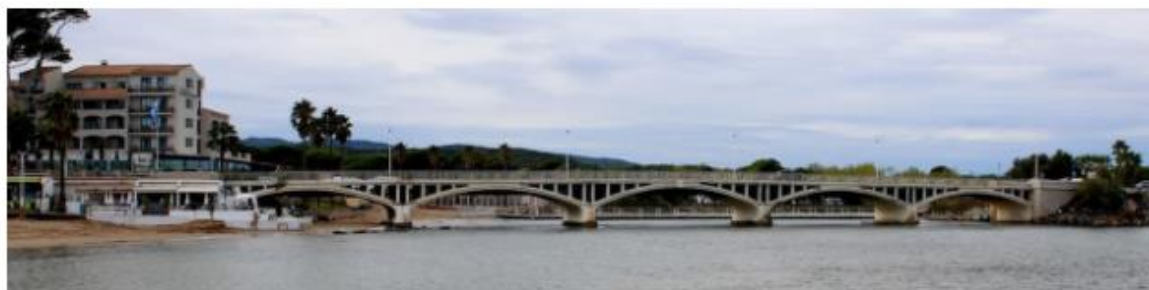
Figure 5. Aperçu du pont actuel (source : ARTELIA)
