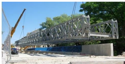
Passerelle modulaire livrée prête à l'emploi
