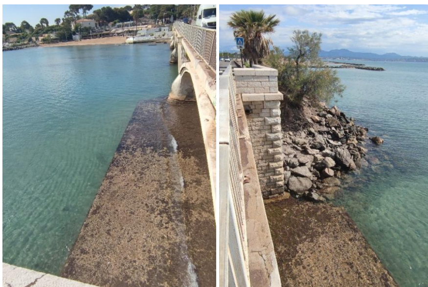
Radier béton et enrochements en rive gauche du pont (EUNIS : C3.7)
