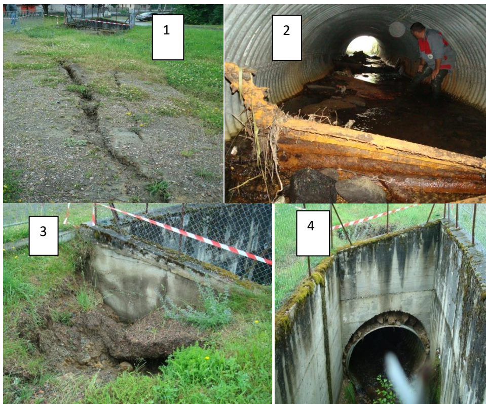
2. Casse de la partie bétonnée canalisée à la sortie de la buse photo4 et photo 5
