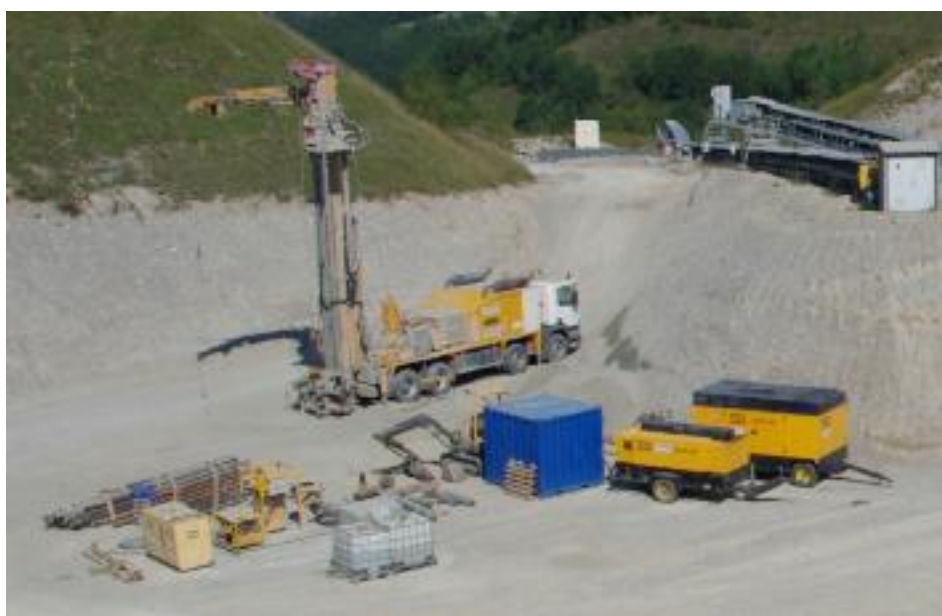
Photographie 1 : Foreuse / compresseur / stockage
