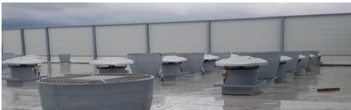
Figure 8 : Exemple d'extracteurs avec un mur anti-bruit
