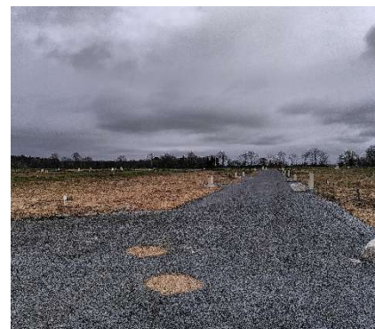
3 : Espaces communs du lotissement « Les Grisous » en cours d'aménagement
