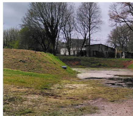
6 : Bassin de gestion des eaux pluviales de l'opération « Les Grisouis »
