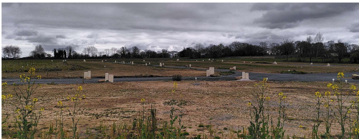
7 : Voiries de déserte de l'opération « Les Grisouis »
