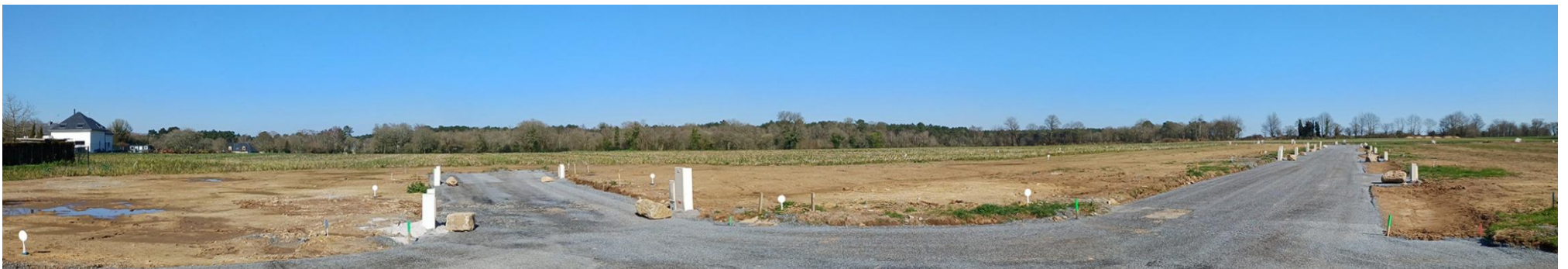
4 : Le projet sera desservi par le lotissement « Les Grisouis 1 », en cours de travaux
