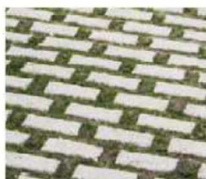
Pavage en béton avec ouvertures de drainage
