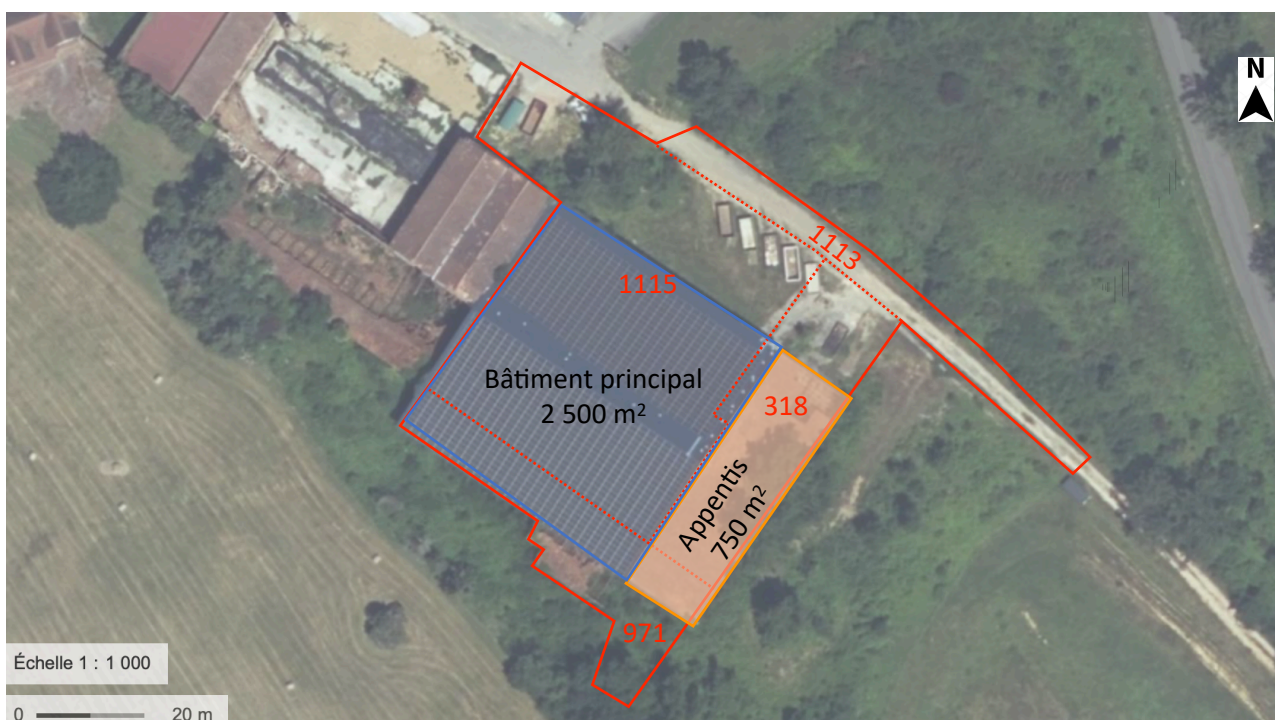
Carte 4 : Vue aérienne des structures actuelles des bâtiments et surfaces avec le découpage cadastrale Source : Géoportail - BIOGRAM 06/2026
