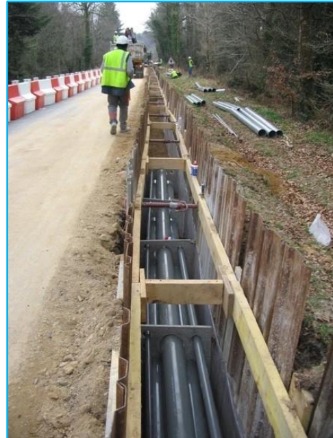
Figure 9 : Vue en coupe et illustration de la pose en fourreaux PVC
