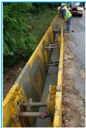
Pose en bord de chaussée
