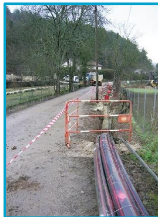
Figure 14 : Exemples d'emprises lors d'un chantier de pose de câbles électriques souterrains (Source : RTE)
