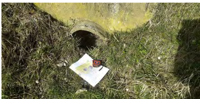
Vue de l'exutoire de la buse sous la Route des Cotes
