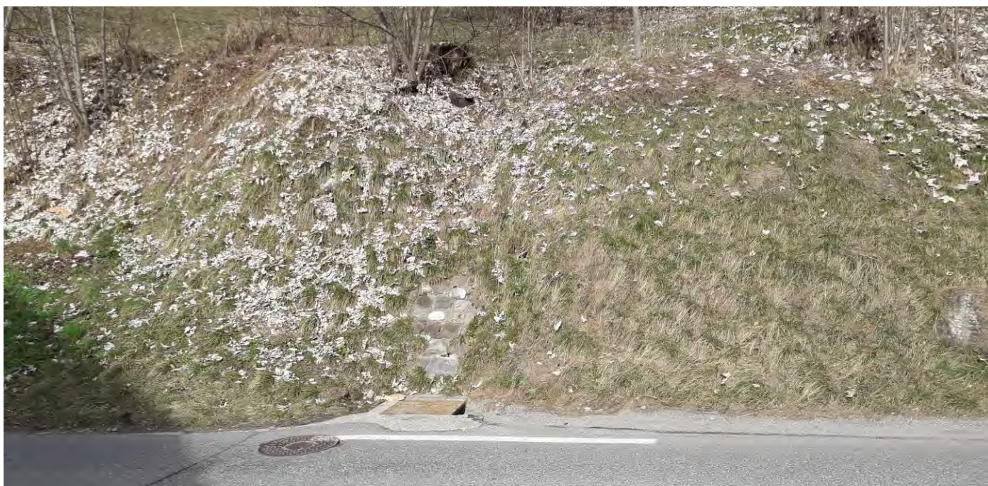
Vue de l'exutoire de l'axe d'écoulement au droit de la Route de l'Echaillon
