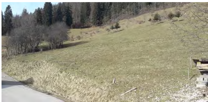
Vue de l'axe d'écoulement en amont du busage de la Route des Cotes
