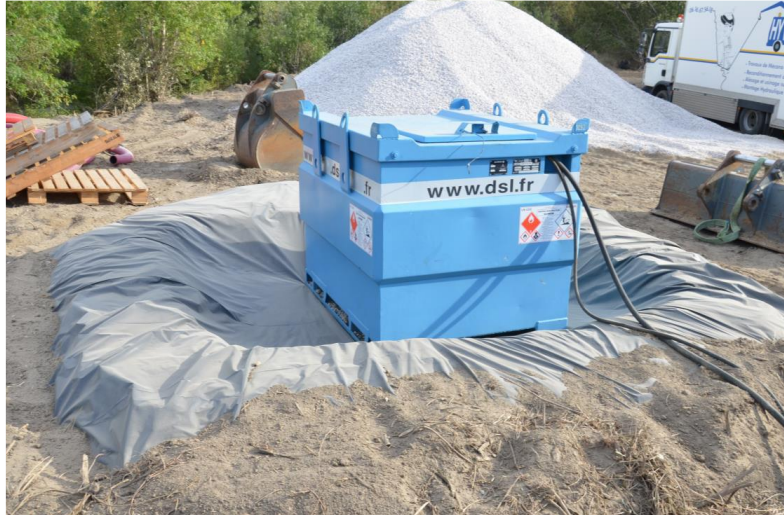
☞ Photographie 8 : Mise en place d'une aire étanche autour d'un groupe électrogène
