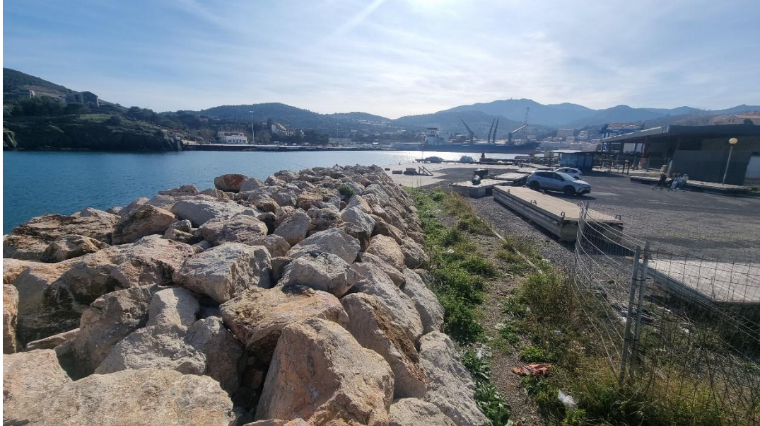
☞ Photographie 4 : Enrochement de protection
